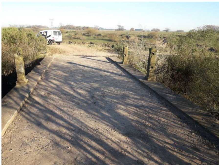
Figura 8.5 - Puente metálico existente.
