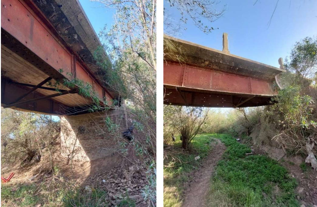
Figura 8.6 - Puente metálico existente, visto desde el canal de derivación.
