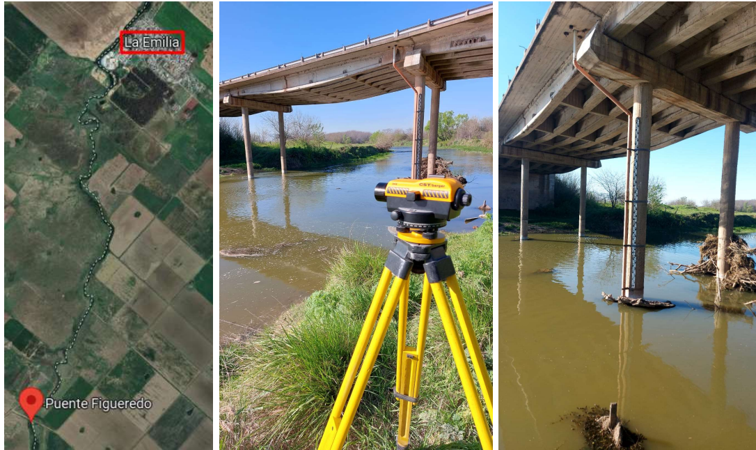
Figura 4.17 - Medición en Puente Figueredo, cercano a La Emilia.
