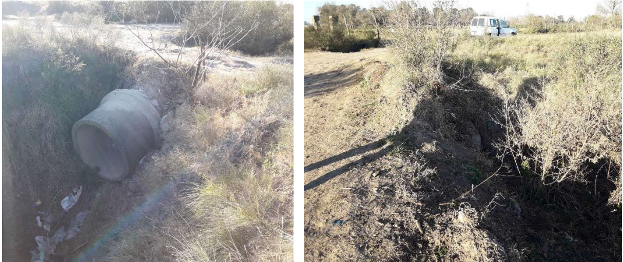
Figura 8.4 - Alcantarilla existente en el acceso al predio.
