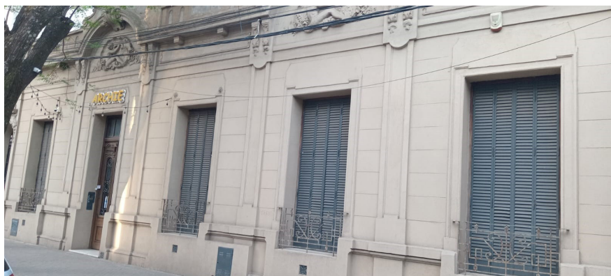
Fachada Petit Trianon. Fuente: elaboración propia.
