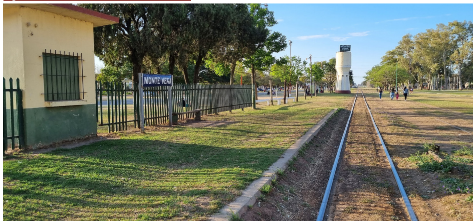
Figura 17. Estación ferroviaria de Monte Vera.
