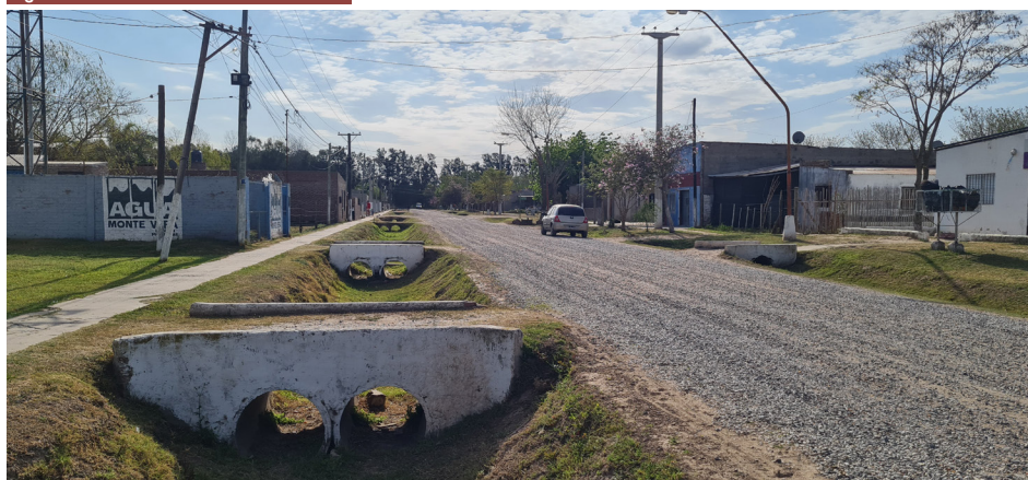
Figura 18. Obra Pública de Monte Vera.
