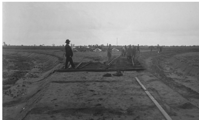
fig. 27. Construcción de vías férreas eleva- das a cota segura. Museo Roca (22 de junio de 2022). Foto de los inicios del barrio Saldías, FCGMB. Año 1930.
