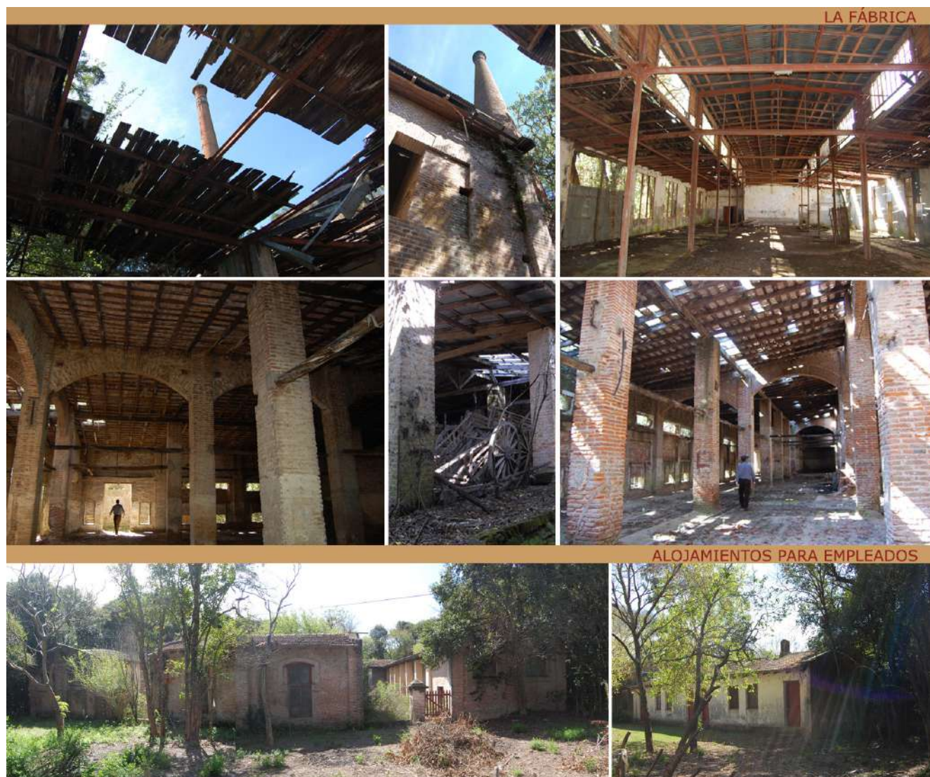
Figura 5.34. Las ruinas de la fábrica de extracto de carne “Puerto Márquez”. Fuente: Fotos de la autora.
