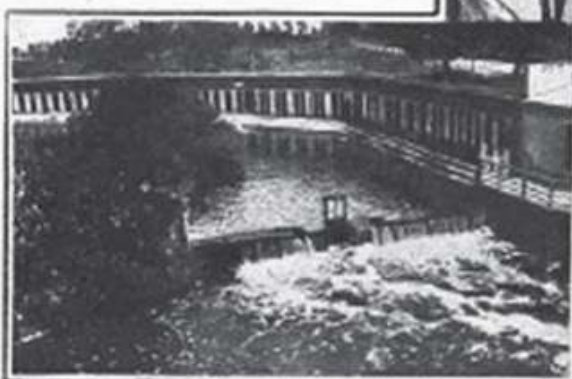
Vista general del balneario
