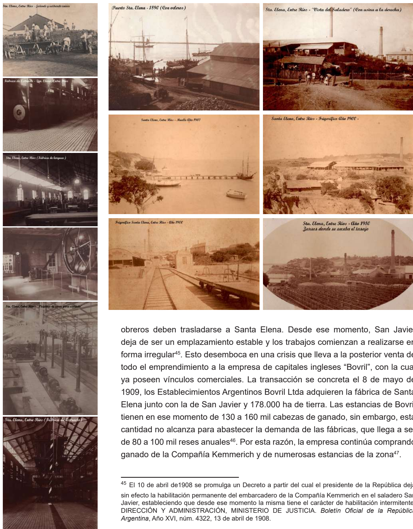
Figura 4.12. Equipamiento, infraestructura y maquinaria en la fábrica de extracto de Kemmerich. Fuente: fotos de la época del Archivo personal de John Giebert.
