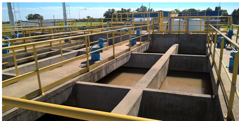
Figura N° 7: Floculadores PPM
