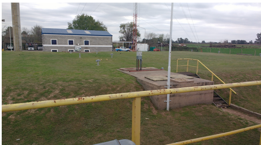
Figura N° 10: Cisterna de agua tratada PPM
