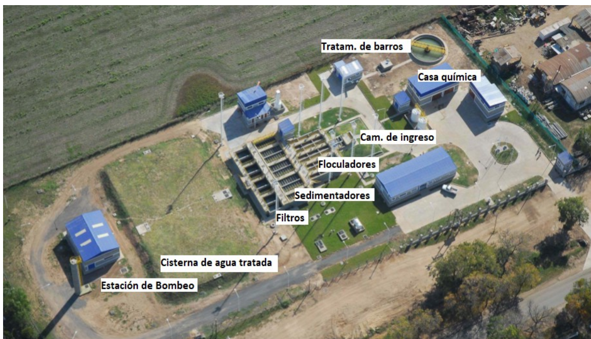
Figura N° 4: Foto aérea de la Planta Potabilizadora de Monje .
