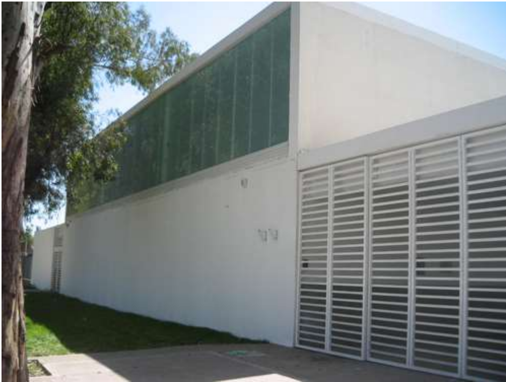
Foto N.º 1: Fachada de la Escuela Técnica N.º 547 23 .
