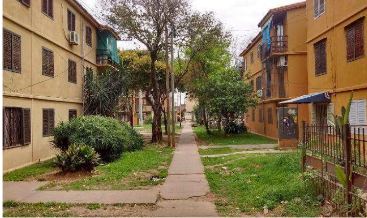
Complejo Supercemento: Tira de PB de + 2 y3 sin ascensor
