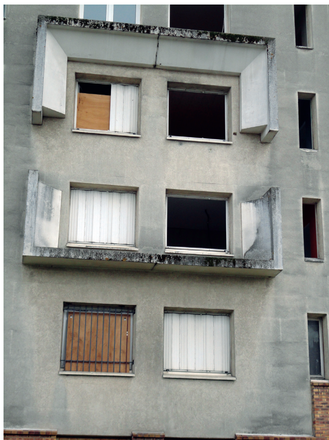
Imagen 2. Demolición de Mantes, 2010, Fotografía del autor.
