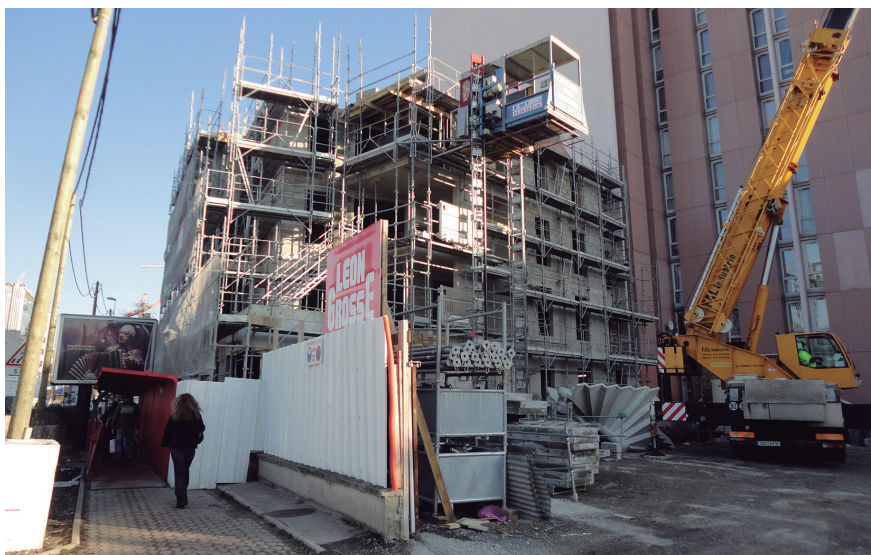
Imagen 4. Demolición y Reconstrucción Gennevilliers Cite Rouge, 2012. Fotografía del autor
