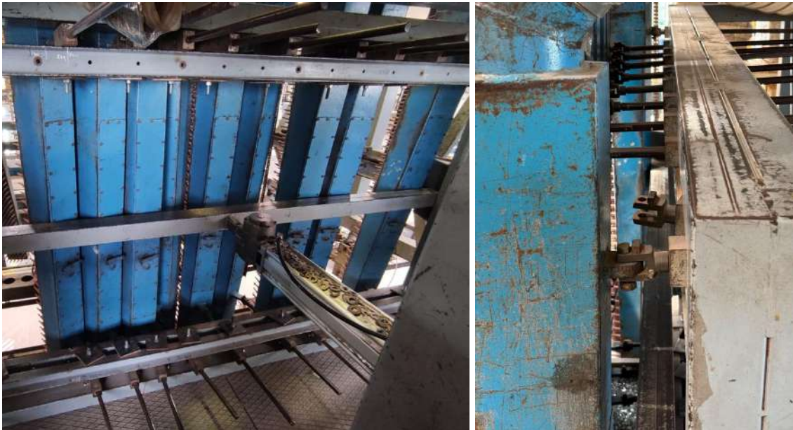
Figura 2-7: Estructura secundaria y vinculación de módulos.
