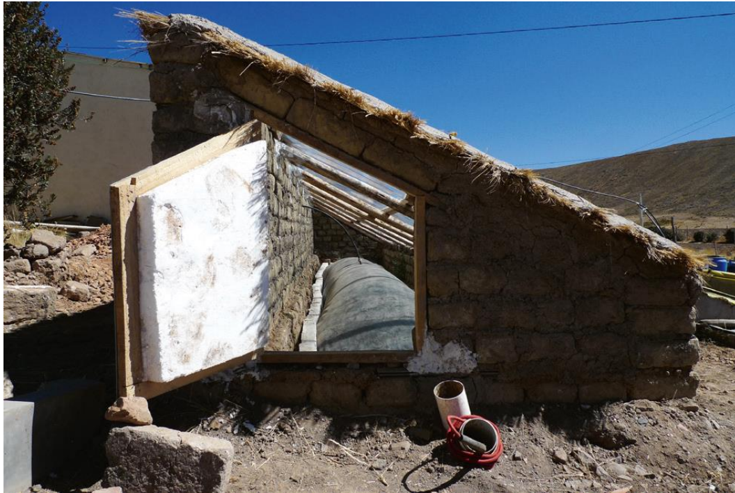
Figura 2-2: Biodigestor tubular adaptado a condiciones de clima frío [15].
