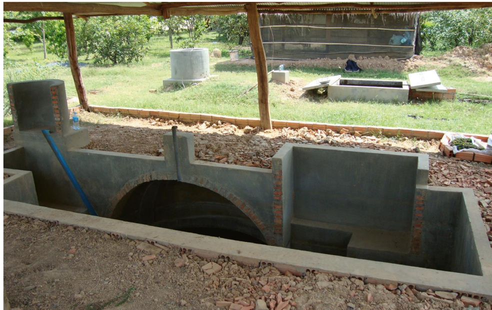
Figura 2-1: Modelo educativo de biodigestor de domo fijo en Camboya [15].
