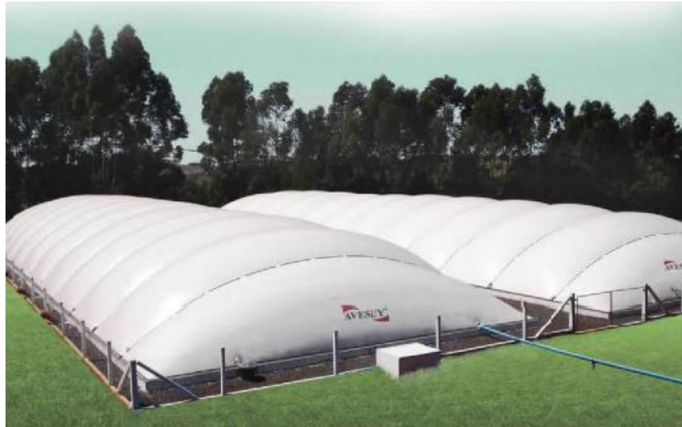
Figura 2-5: Biodigestor de membrana, en este caso usando residuos pecuarios [15].
