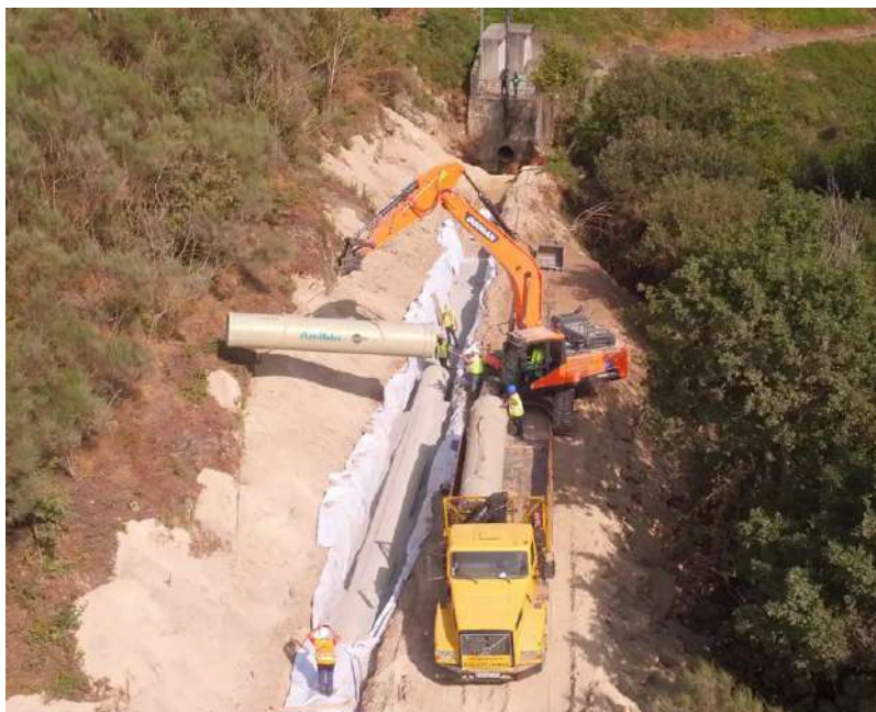
Ilustración 4: Instalación de una tubería forzada de PRFV DN 1000 en la central hidroeléctrica de Ovadas, Portugal. [19].
