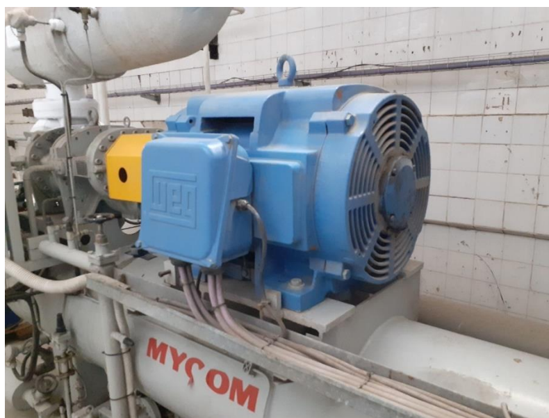
Figura 7.2.3: Motor 300HP Girofreezer.
