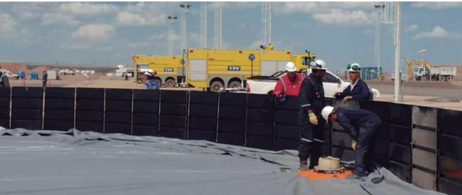
Según especificaciones dadas por la propia empresa, los tanques desmontables tienen una vida útil que depende de su manipulación, principalmente en fases de armado y desarme, ya que la lona suele dañarse al entrar en contacto con objetos que se encuentran en el piso.
