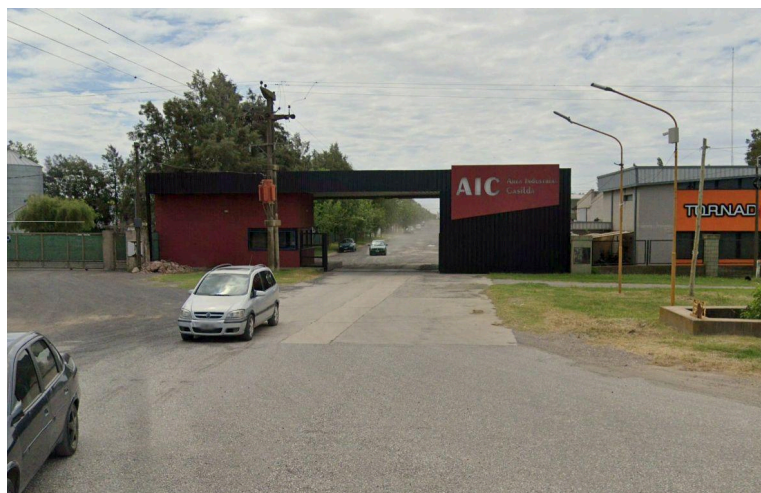
Fotografía 6: Ingreso al parque industrial existente. Fuente: Elaboración propia.
