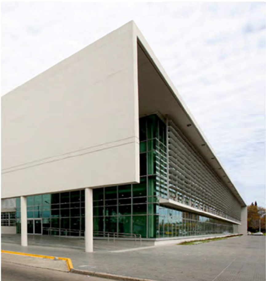
Hospital de Emergencias "Clemente Alvarez"
