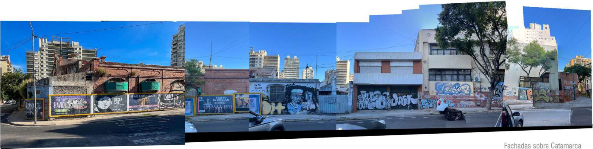
Fachadas sobre Catamarca
