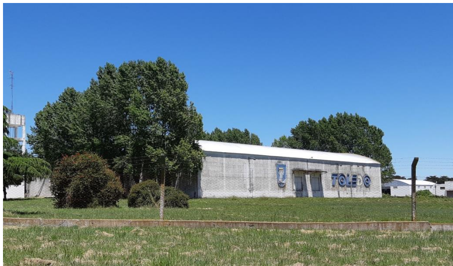
Figura 4.9. Criadero de pollos "Toledo" en el área periurbana sobre ruta 226
