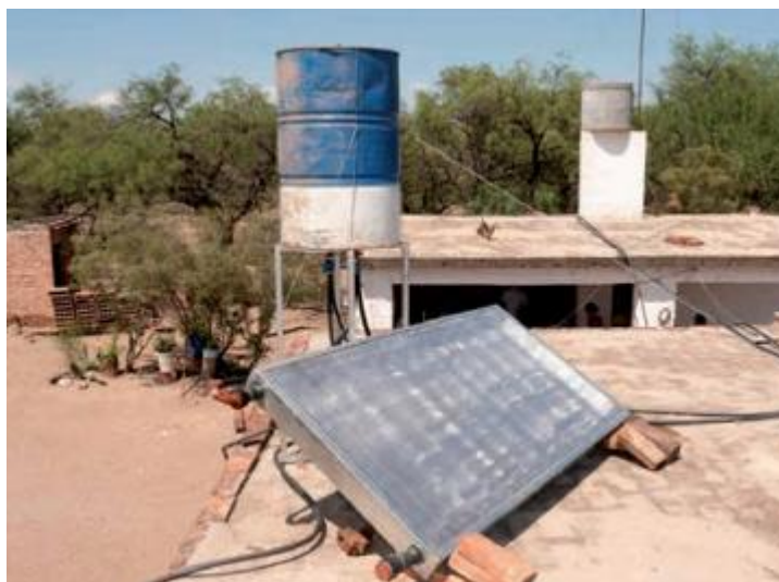
Figura 3.17: Calefón solar de 100 litros fabricación casera Fuente: INTA – Manual paso a paso para construcción de termo tanque solar de agua
