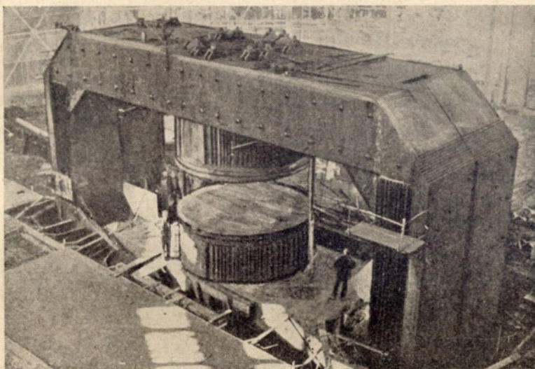
Fig. 6. — Armadura y polos del electroimán de 4.000 toneladas en plena construcción iniciada en 1940. El diámetro de las "Dees" de este gigantesco aparato es igual a 5 metros aproximadamente. Ha sido planeado para producir partículas aceleradas de más de 100 millones de electrón-voltios.
