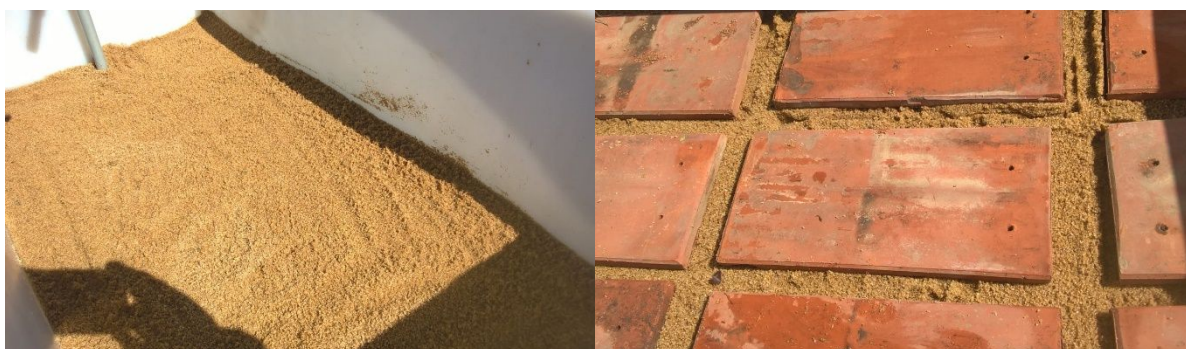
FIGURA 61: PROCESO DE ARMADO DE LAS PLAYAS-MANTOS SUPERIOR DE ARENA Y TEJUELAS
