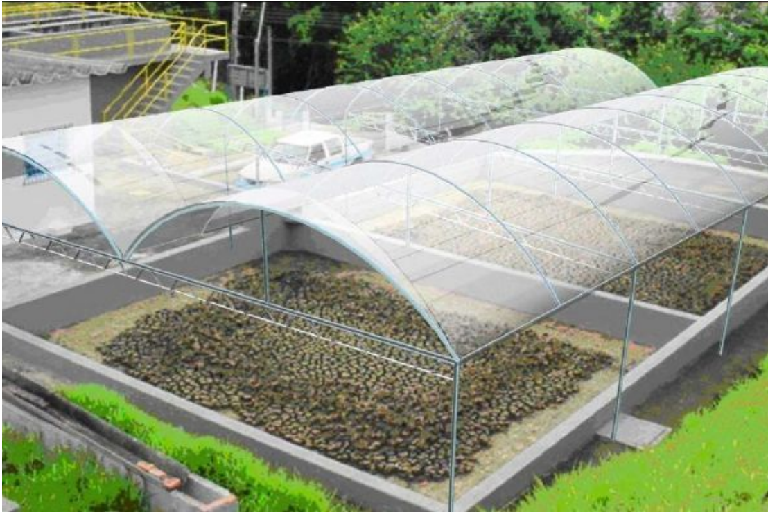
FIGURA 20: ESQUEMA PLAYAS DE SECADO CUBIERTAS, PLANTA DE TRATAMIENTO DE EMBAÚ, CACHEIRA PAULISTA-SP
