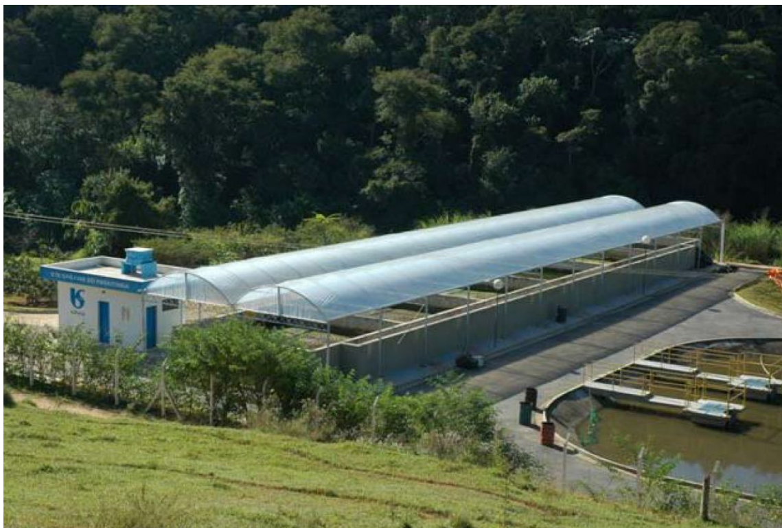
FIGURA 19: PLAYAS DE SECADO CUBIERTAS, PLANTA DE TRATAMIENTO SAO LUIZ DO PARAITINGA (FUENTE: FELCIO DOS REIS ET AL, 2011)
