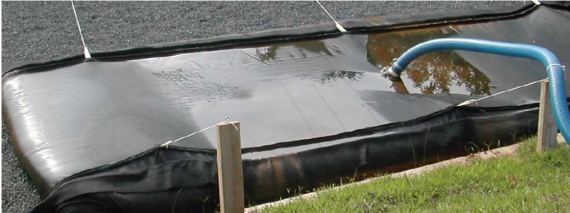
FIGURA 23: BAGS INSTALADOS EN LA PLANTA DE SAN ANTONIO-SP (Q=15L/S)
