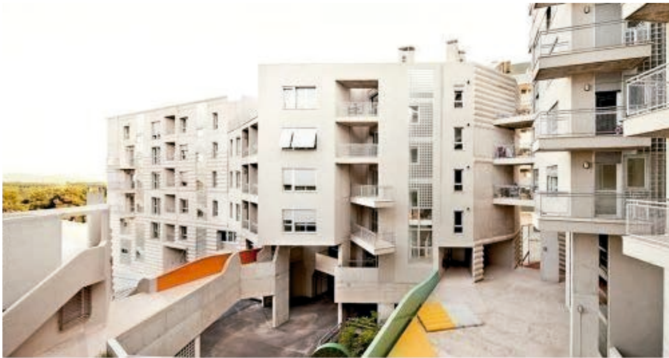
Edificio 111 Flores & Prats
