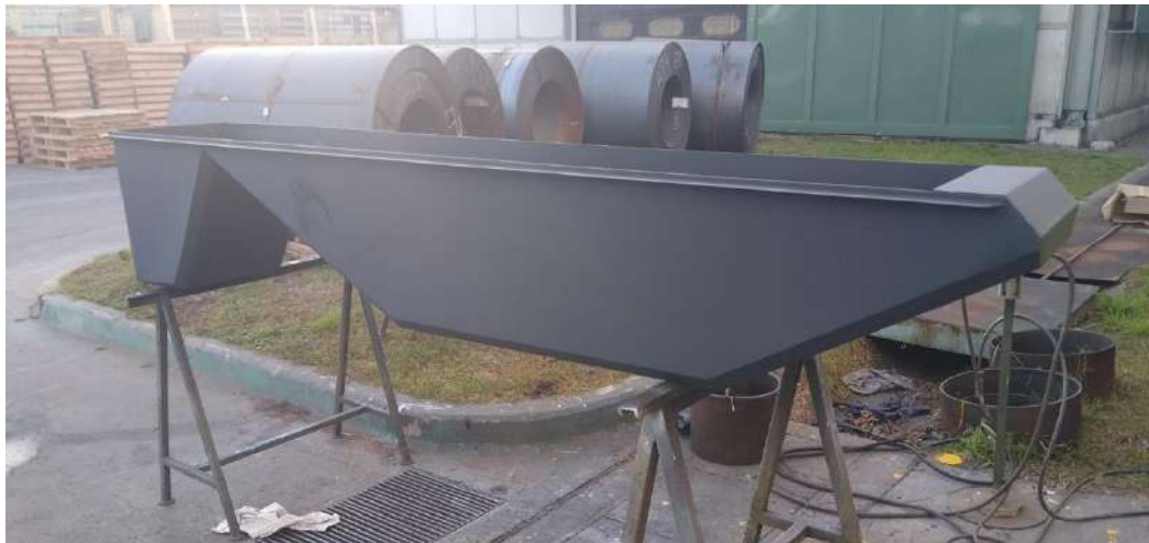
Figura 4-7: Construcción cuba de pintura
