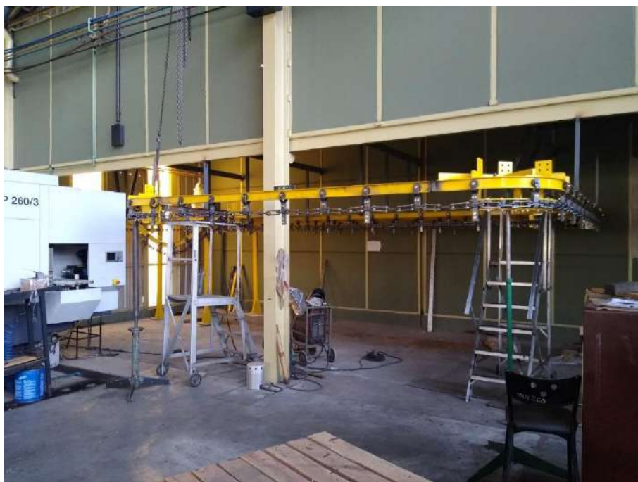
Figura 3-6: Montaje estructura recorrido
