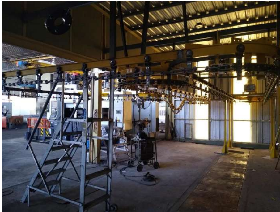
Figura 3-5: Montaje estructura recorrido
