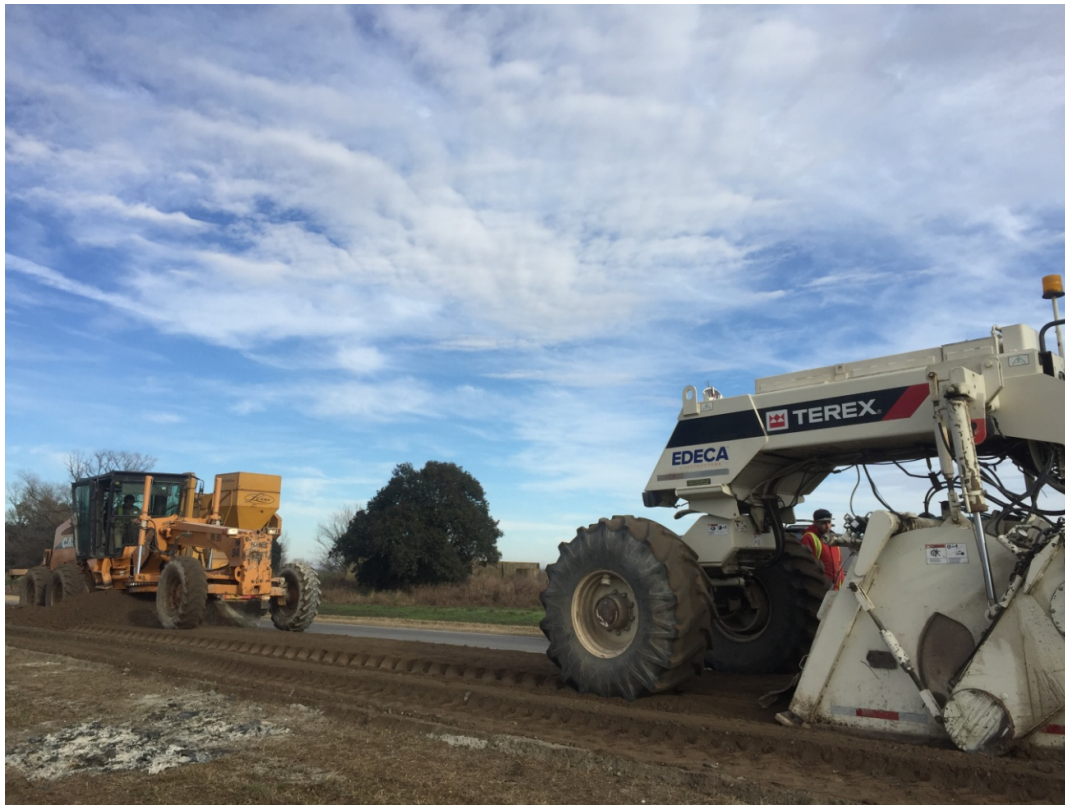
Figura 5.3. Perfilado del material ya mezclado con el estabilizante.
