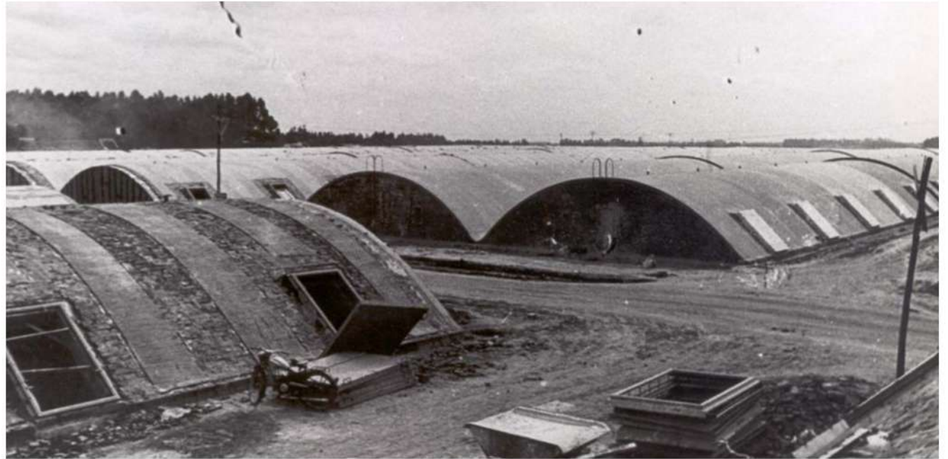
Silos subterráneos en funcionamiento
