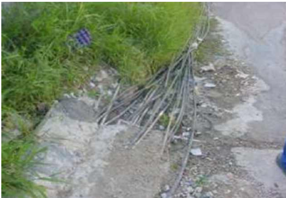
Figura n° 25: Conexiones clandestinas
