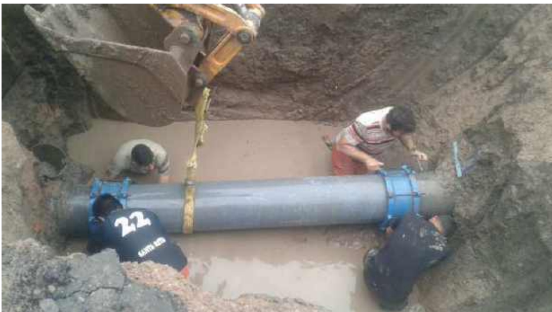
Figura n° 19: Reemplazo de tramo de cañería maestra vinculando con uniones FD
