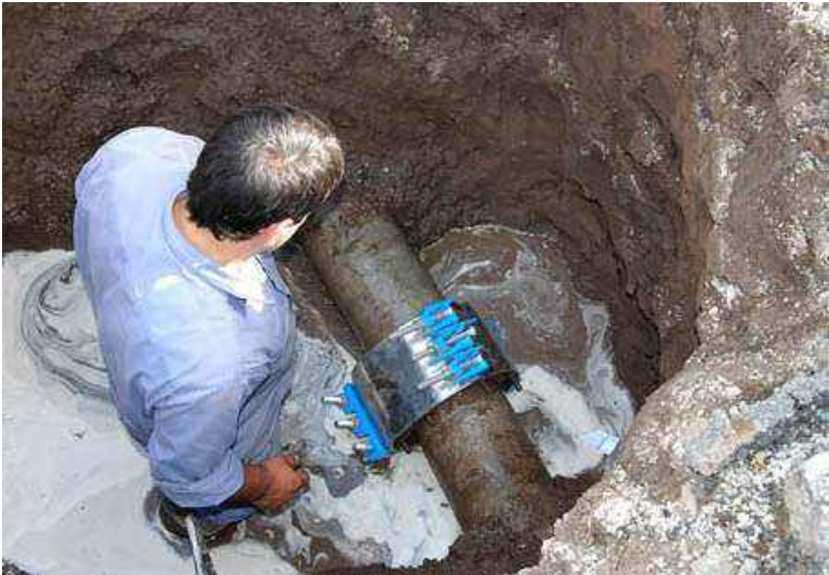
Figura n° 18: Cañería maestra reparada con junta de reparación
