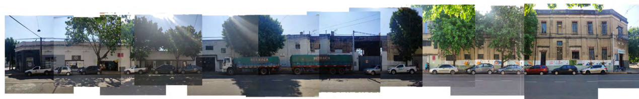
Fachada Ov. Lagos
