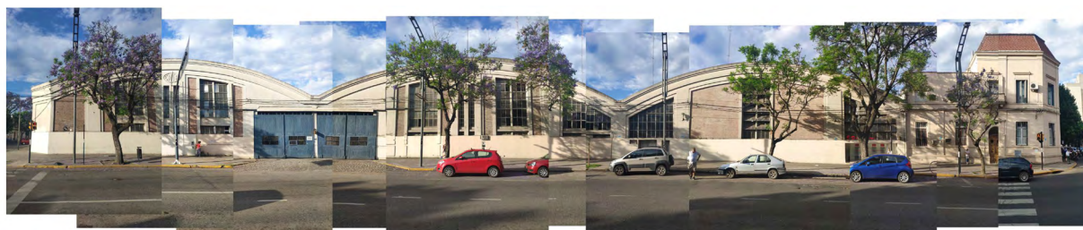
Fachada Av. Pellegrini
