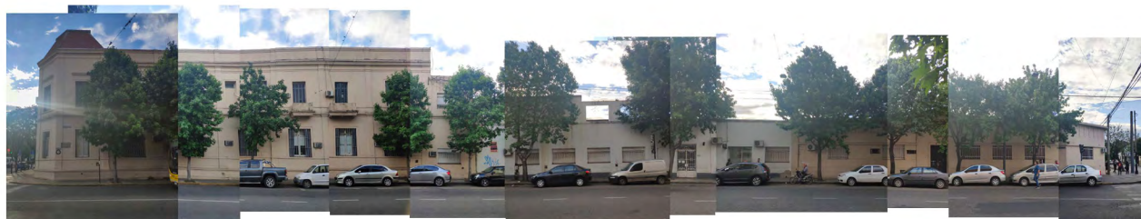
Fachada Ov. Lagos
