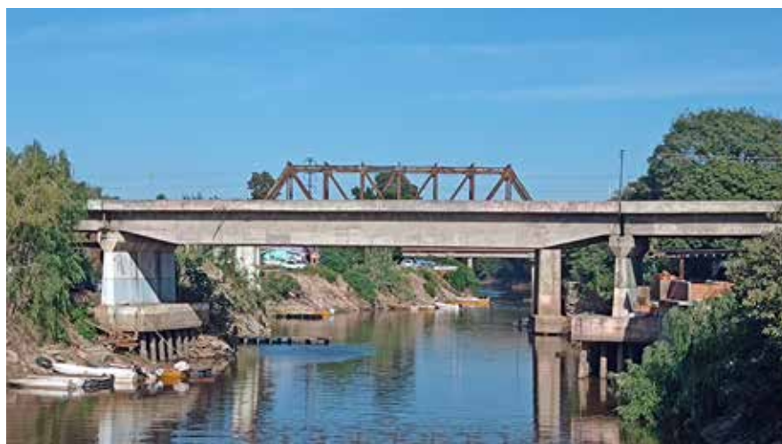
Puente ferroviario sobre Arroyo Saladillo
