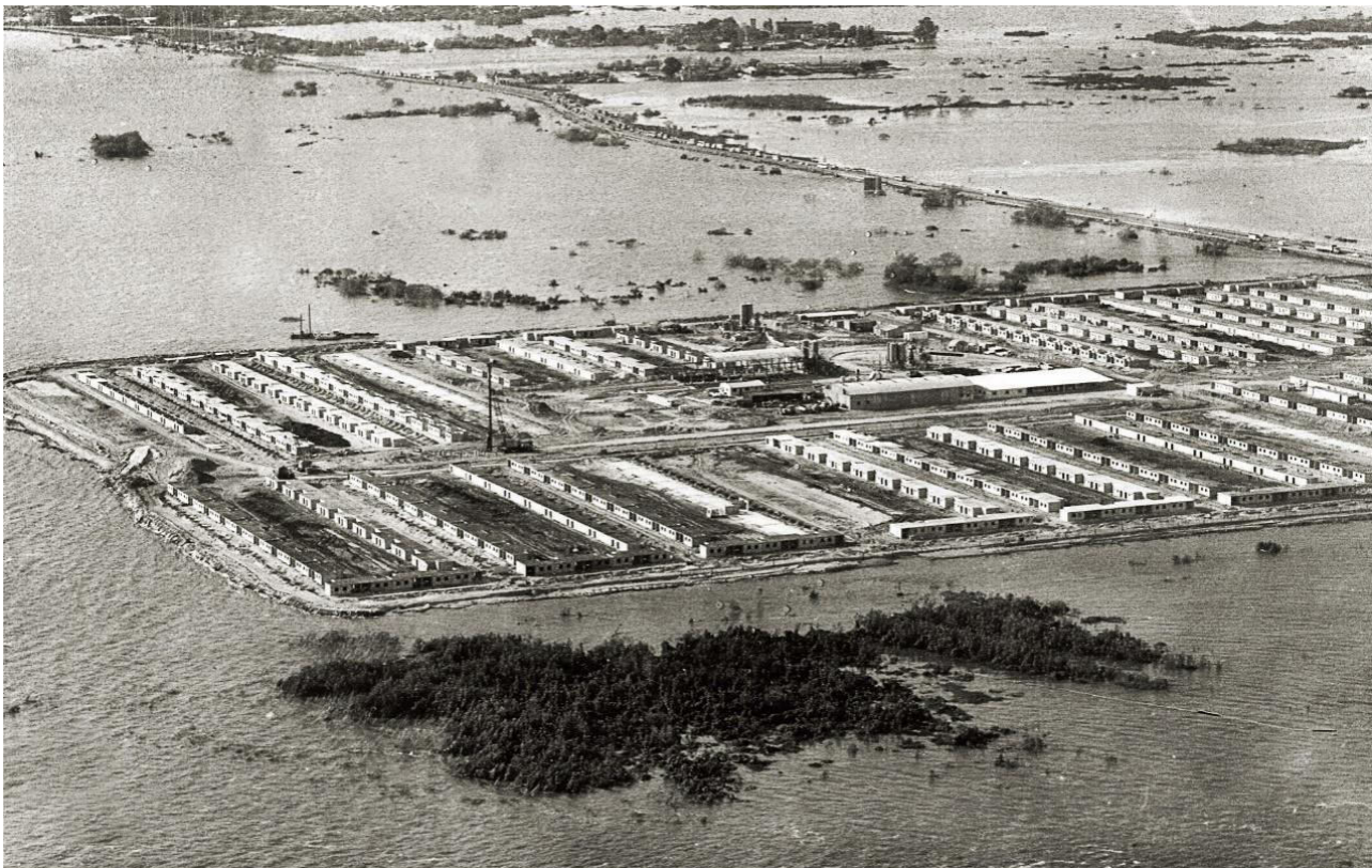
Figura 27: FONAVI "El Pozo" en proceso de construcción en la inundación de 1983.
