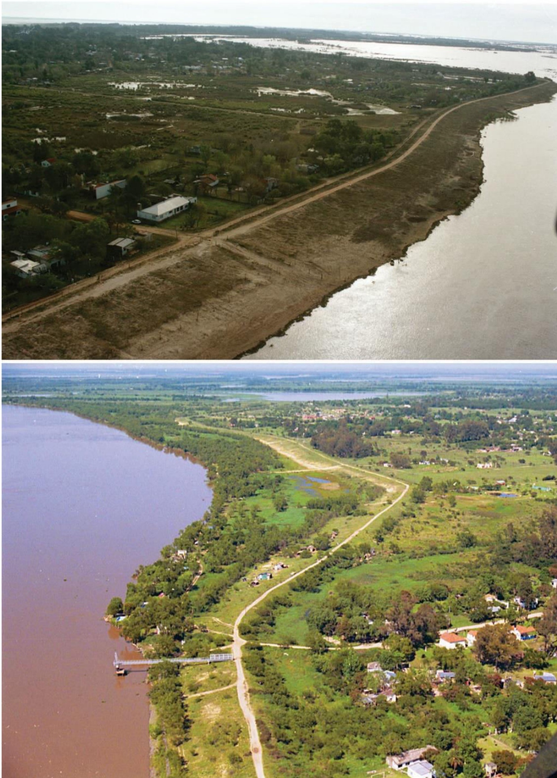
Figura 59: arriba: zona de San José de Rincón, durante años de ejecución de defensas (1997). Abajo: Colastiné (2002).
