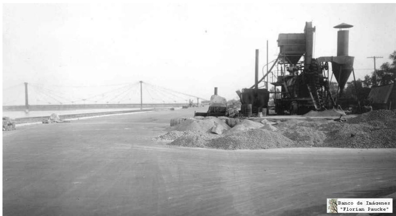
Figura 18: obras de construcción de Av. Costanera 1940.
