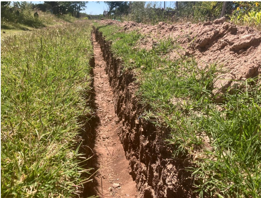
Fotografía n° 3 : Nuevo sistema de riego en construcción
