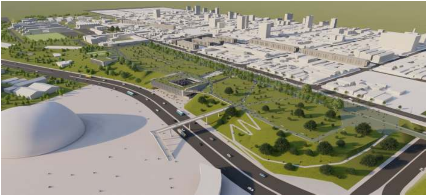
Imagen semiaérea de la intervención
