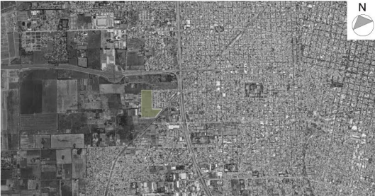
Aproximación al área de intervención
