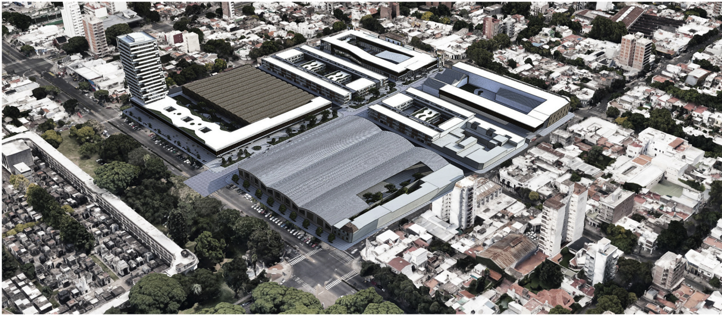
Imagen semiaérea de la intervención
