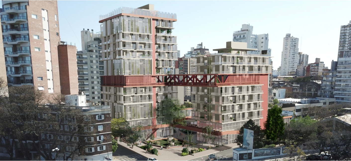
Imagen semiaérea de la intervención
