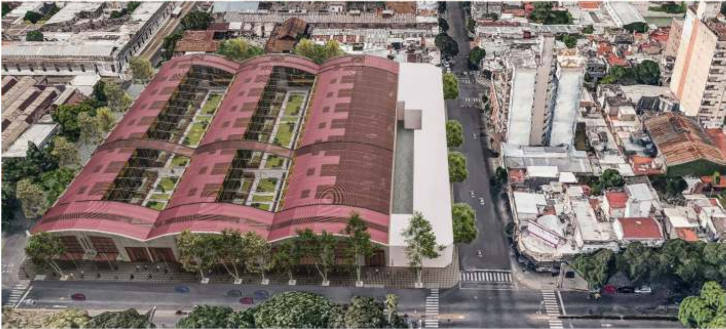
Imagen aérea de la intervención
