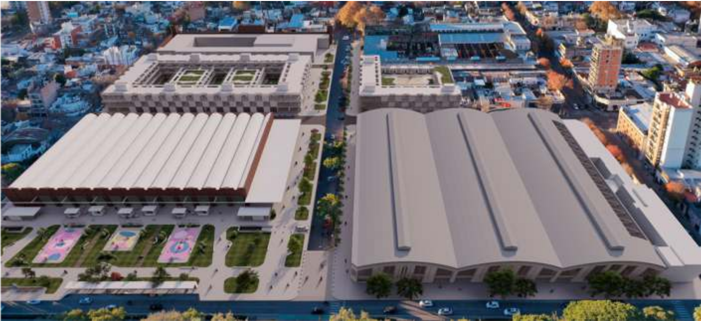
Imagen semiaérea de la intervención
