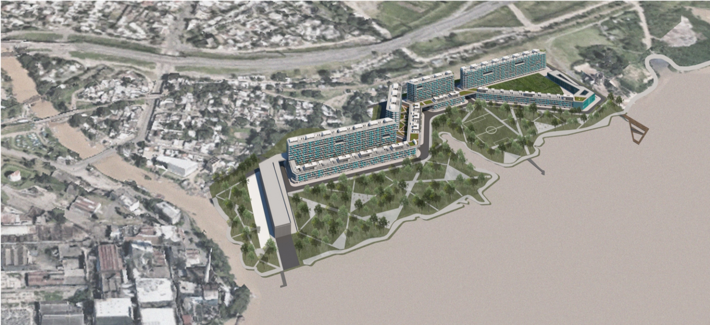
Imagen semiaérea de la intervención
