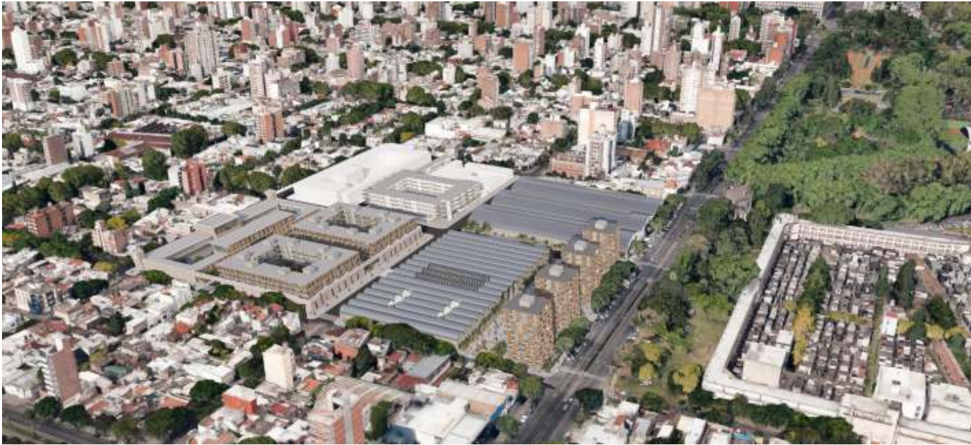
Imagen semiaérea de la intervención
