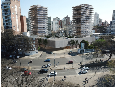
Imagen semiaérea de la intervención
