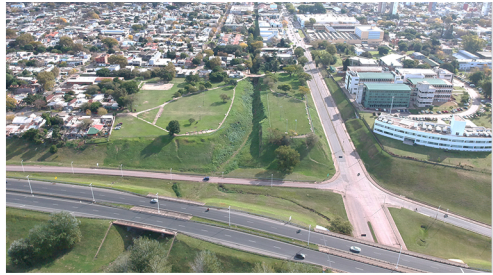
Fotografía del área de intervención
