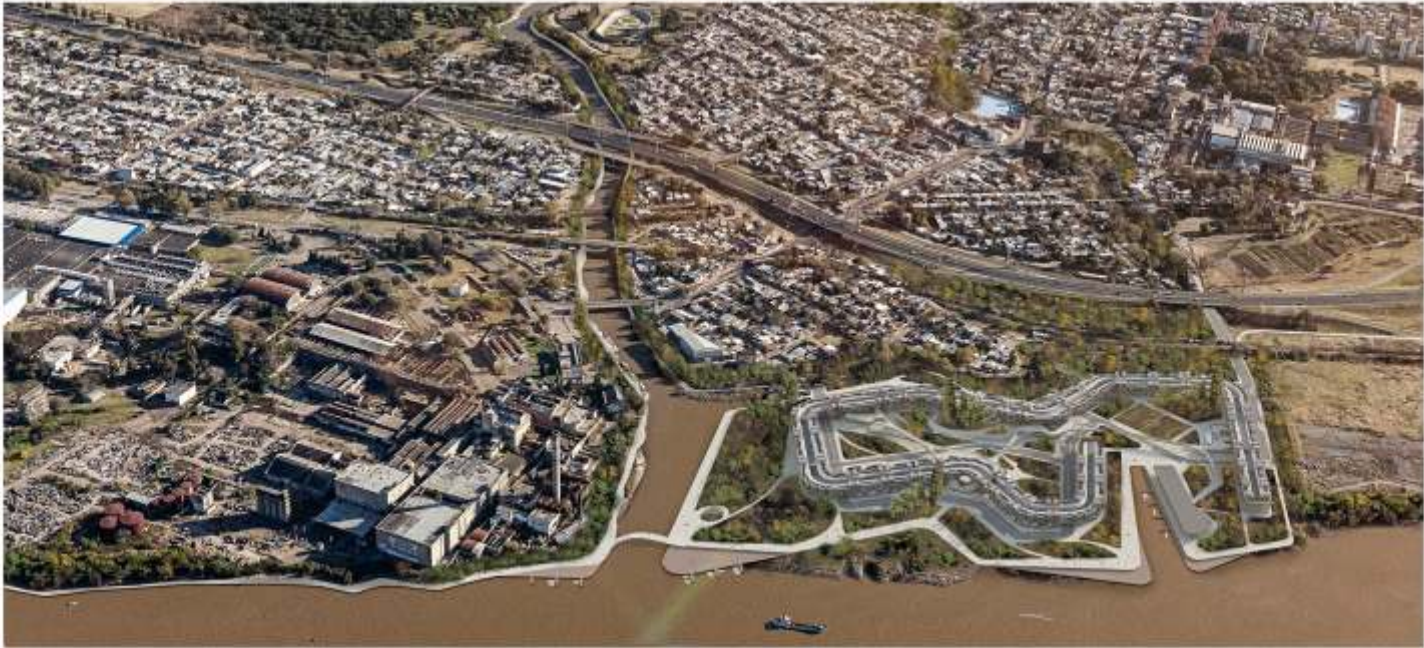
Imagen semiaérea de la intervención
