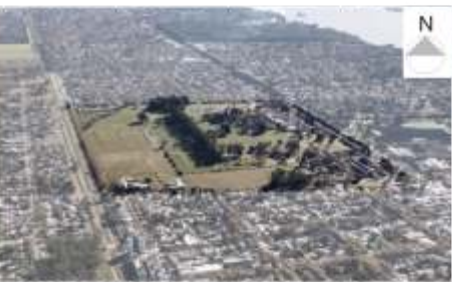
Fotografía del área de intervención
