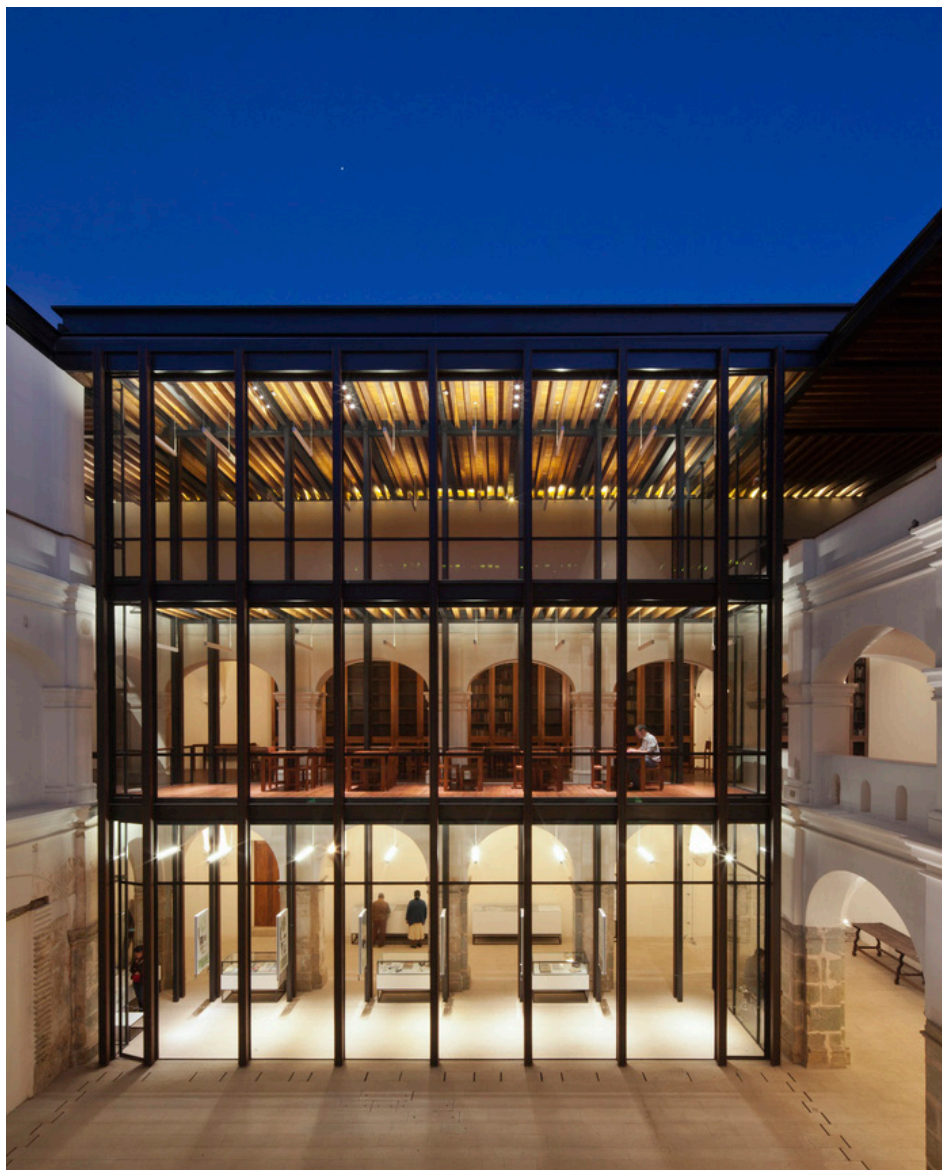
PFC | CALDERONI - GUARDALÁ
