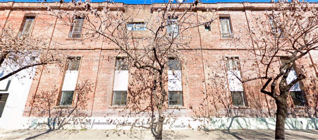
Fachada Escuela Técnica n° 288° Osvaldo Magnasco - calle Ov. Lagos y Zeballos
