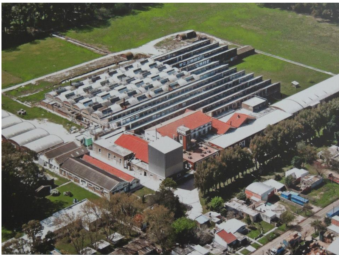
Foto: Vista aérea Planta Faiart SA en repositorio fotográfico página web empresa
