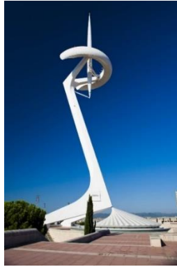
Figura N°40: Santiago Calatrava Valls (Benimámet, 1951), arquitecto, ingeniero civil y escultor español “Torre de comunicaciones” de Montjuic, Barcelona, 1992. 70
