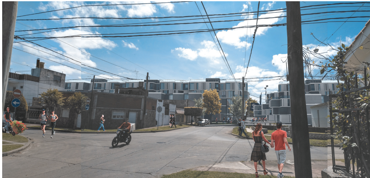
Fig.116 : Cruce de calles. Vieytes y Darregueira. Despues
