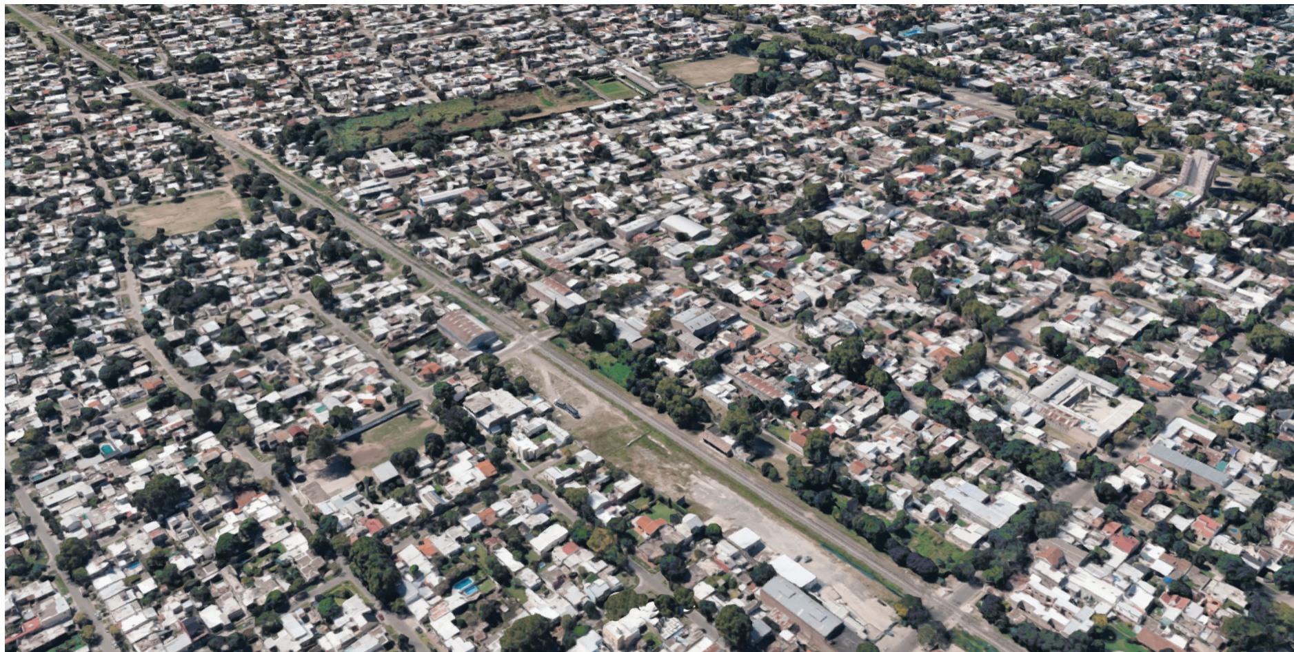
Fig.111 : Sector de intervención. Antes
