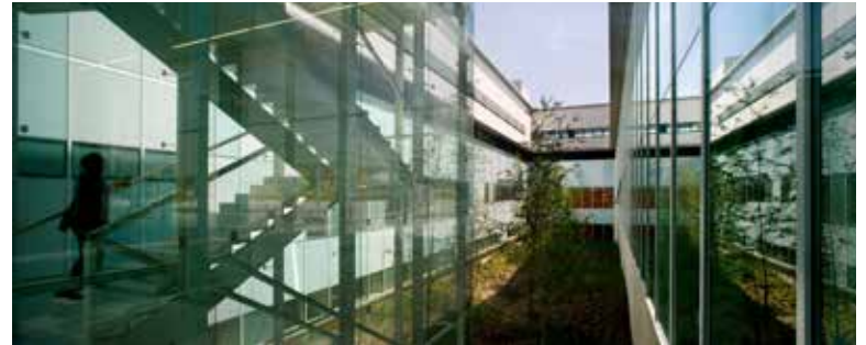
CIRCULACIÓN VERTICAL EN PATIO HOSPITAL DE MOLLET Mollet del Vallès, Barcelona, España (2010)
