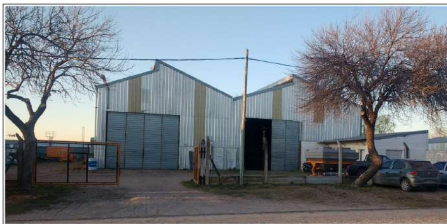
Figura 65: Vista exterior de la empresa.
