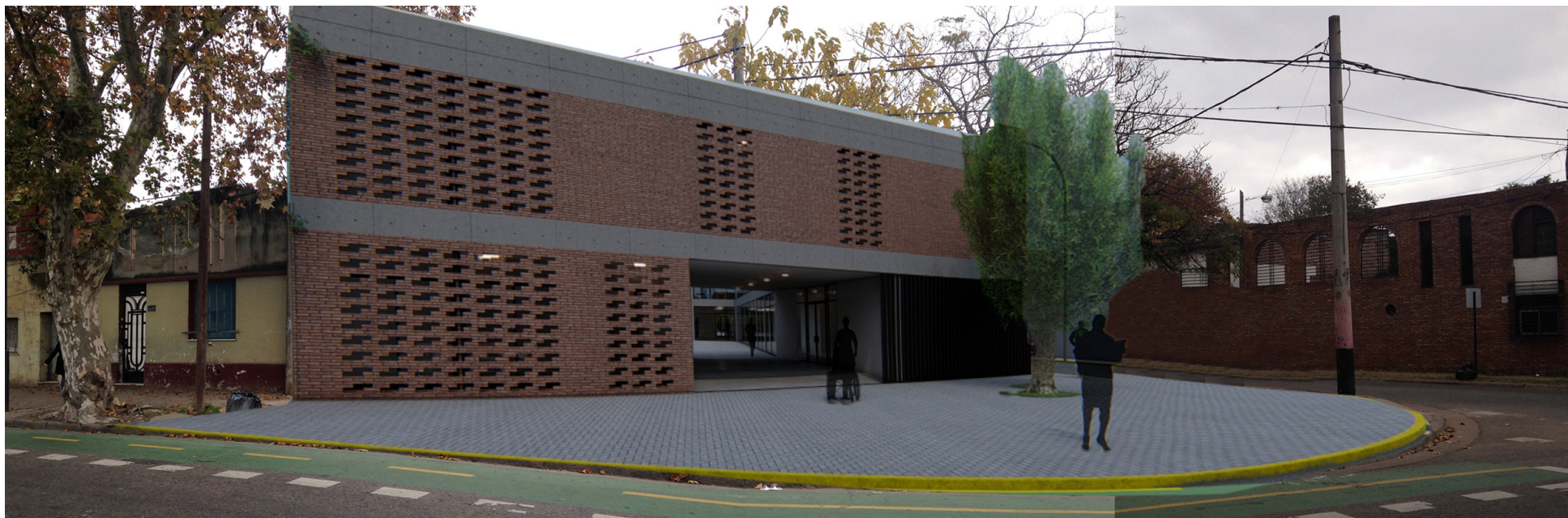
Fig.73: DESPUES: Foto de ingreso al CCB lonja1 por calle Riobamba. Imágen de autora.
