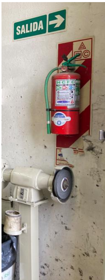
Salida de Emergencia C
