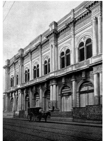
Fachada en construcción del Teatro Colón c.1902
