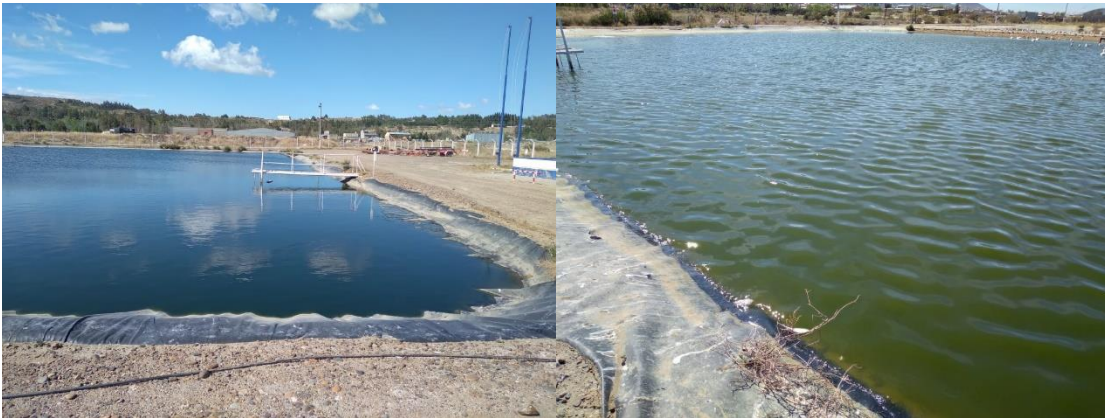
Laguna de maduración
