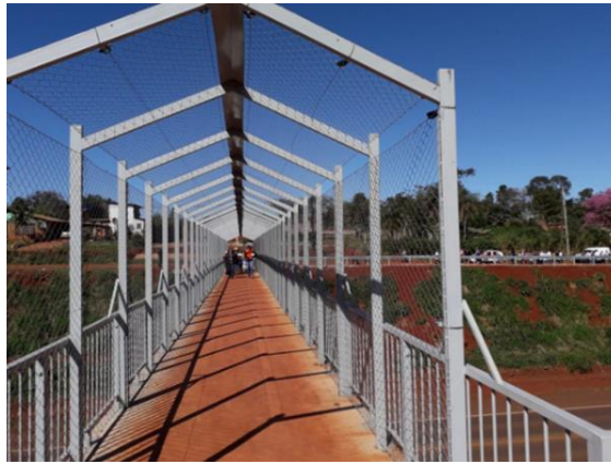
Ilustración 39. –Baranda y Casilla metálica en pasarela principal.
