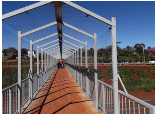
Ilustración 46. – Baranda y Casilla metálica en pasarela principal.
