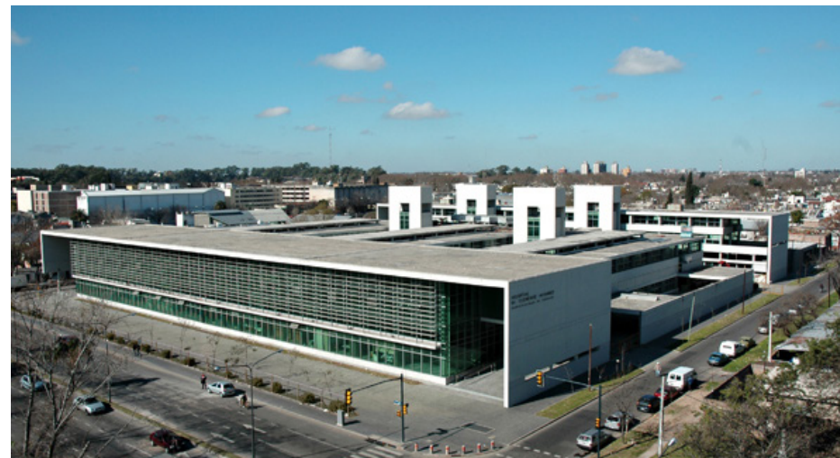
Vista aérea HECA (Hospital de Emergencias Clemente Álvarez). Arq. Mario Corea. Rosario, Argentina. (2008)
