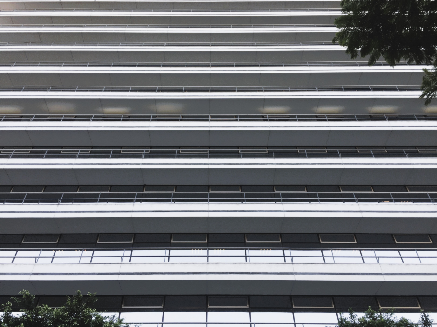
F26 La imagen muestra la asociación entre la organización constructiva y material en tensión con la identidad formal en el edificio American Express. Esquina Arenales y Maipú. Bs. As. Mario Roberto Álvarez, Arquitecto. 1987-1989
