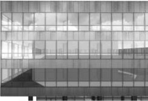
Secuencias de antepecho aluminio y carpintería vidriada espejada.
