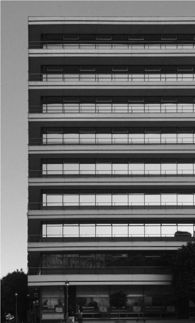
F1 La imagen muestra el frente del Edificio de American Express en la esquina de la Avda. Maipú, en la Cdad. de Buenos Aires.
