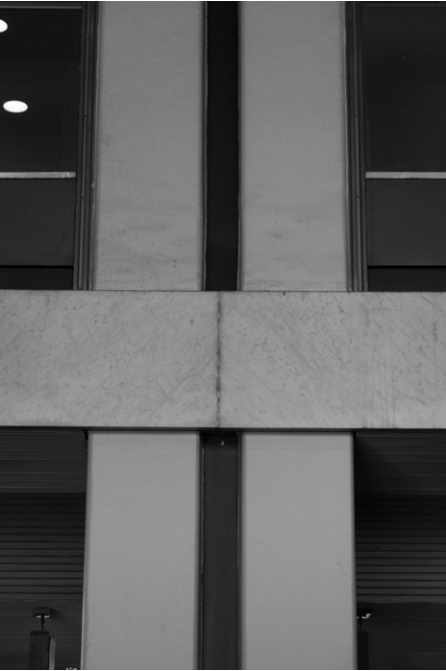
F36 Detalle del edificio de la Bolsa de Comercio de Buenos Aires (1987-1989), proyectado por MRA+A. Vista del frente sobre la Avenida Leandro N. Alem. La imagen muestra la forma del pilar de hormigón con perfil doble T y su encuentro con la losa revestida en placas de mármol, lo que acentúa el eje vertical de la columna y refuerza el carácter singular del conjunto.
