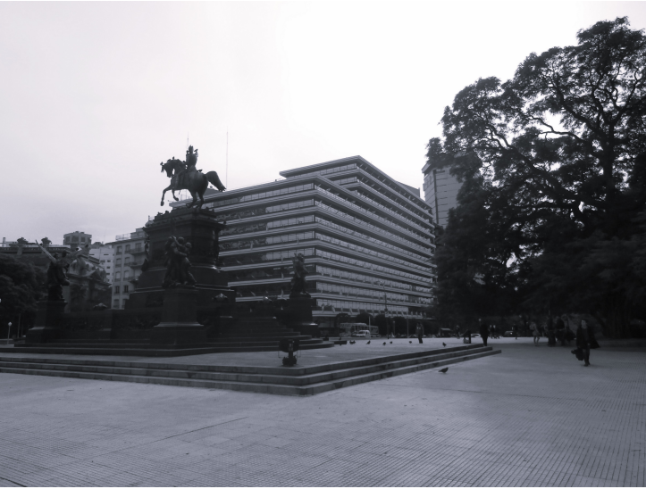
F7 Vista del edificio de Plaza San Martín, también llamado Américaexpress. Ubicado en calle Maipú esquina Arenales,
