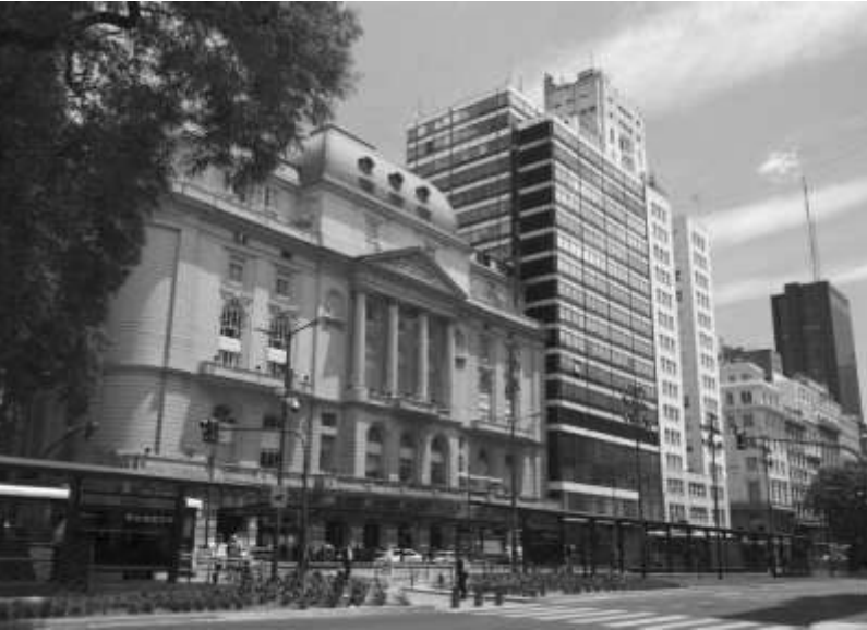
Fachada Leandro N. Alem: El cerramiento vidriado y espejado de la torre acciona relaciones convergentes urbanas reforzando los vínculos del emplazamiento y acentuando las diferencias. El contexto es determinante de la materialidad constructiva.
