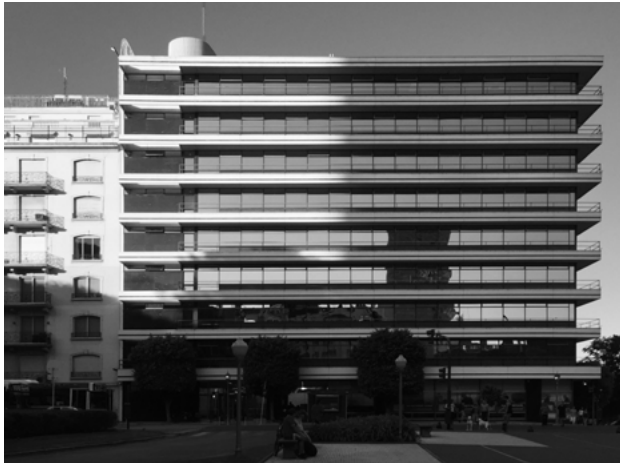
F18 La imagen muestra el entramado material y el remate con el edificio aledaño.
