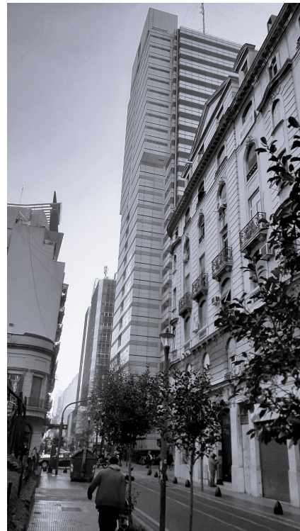
F4 La imagen muestra la configuración constructiva del edificio Intercontinental (1992/94) en Bs. As. proyectado por Mario Roberto Álvarez, en contraste con la organización constructiva y material tradicional de edificios de las primeras décadas del siglo XX.
