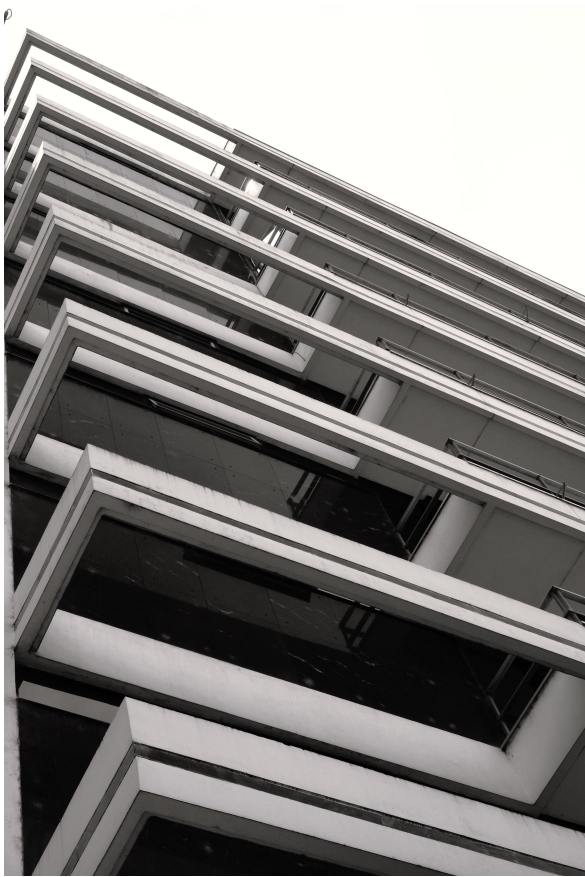
F53 Las imágenes muestra el Edificio Américanexpress en Bs. As. La solución constructiva plantea el momento visual intensivo entre los componentes y elementos a través de la sintaxis constructiva.
