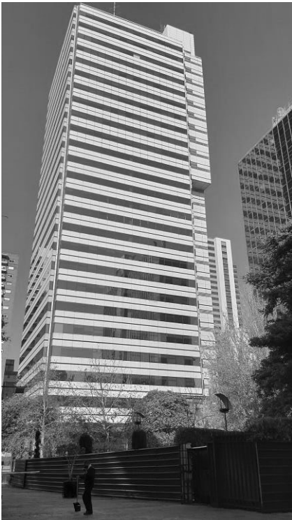
F44 La imagen el muestra edificio Intercontinental donde la voluntad volumétrica resulta de las superficies pulimentadas retrayendo la tectonicidad y perdiendo consistencia el atributo sintáctico constructivo. Ph. D. Gelardi 2022
