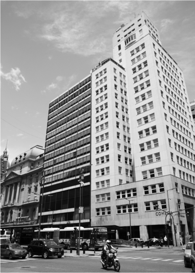
F28 Imagen del Edificio Bolsa de Comercio de Bs. As. (1972/76) Frente sobre la Av. Leandro N. Alem. La técnica es la efectiva realización del dominio de los materiales y muestra del ciclo de concebir la forma
