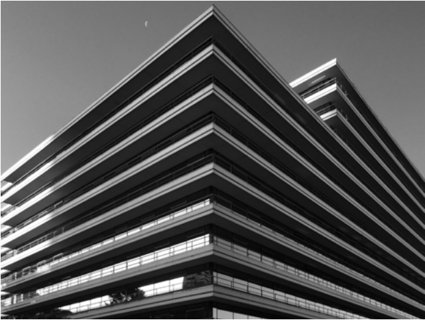
F37 La imagen muestra la esquina del edificio Americanexpress en la intersección de las calles Maipú y Arenales en la CABA. La regularidad del entramado de carpintería con cristal espejado y los elementos en conjunto, se vinculan y coordinan con la horizontalidad de las bandejas de los forjados. Las molduras bajo relieve resaltadas por granito negro en cada una de las bandejas subrayan la horizontalidad y las juntas de los elementos aplicados marcan la métrica del entramado estilizando la gramática constructiva.
