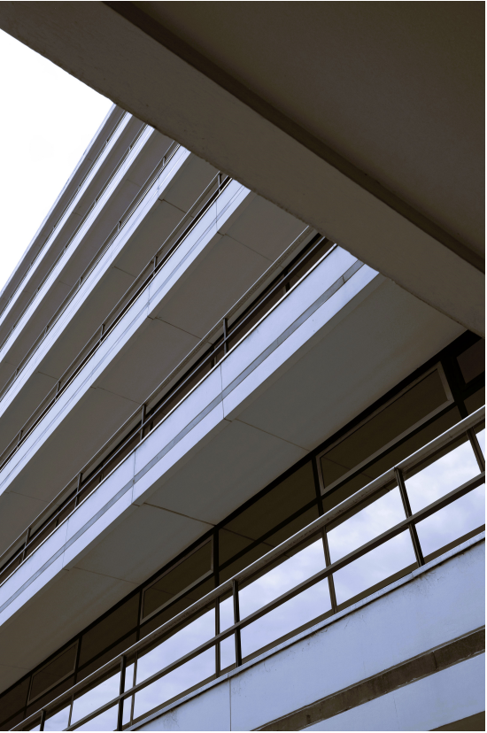
F32 La imagen muestra la pauta modular y constructiva que regula la asociación entre los elementos de la arquitectura. Edificio American Express. Esquina Arenales y Maipú. Bs. As. Mario Roberto Álvarez, Arquitecto. 1987-1989
