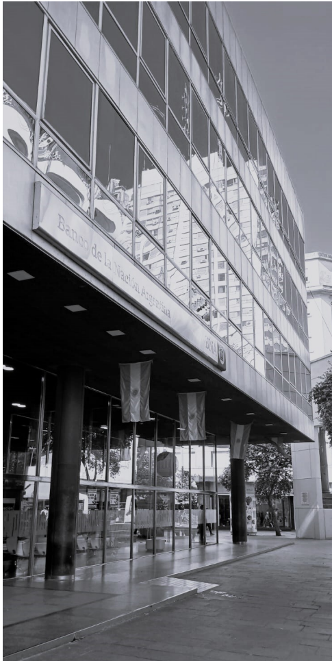
F47 La imagen muestra el Edificio Banco Nación de Rosario. Muestra la constante de las reglas constructivas y la sintaxis del lenguaje técnico. La racionalidad técnica y la sistematicidad constructiva es la constante de consistencia material y visual.
