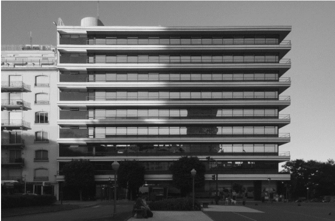
F41 Edificio American Express. La imagen muestra el montaje y fundido de los elementos y la convergencia visual en el frente sobre Arenales.
