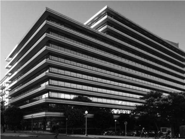
F51 La imagen muestra la esquina del Edificio American express entre calle Maipú y Arenales. La constante sistematicidad del balcón corrido y la regularidad y estabilidad visual de la materialización.
