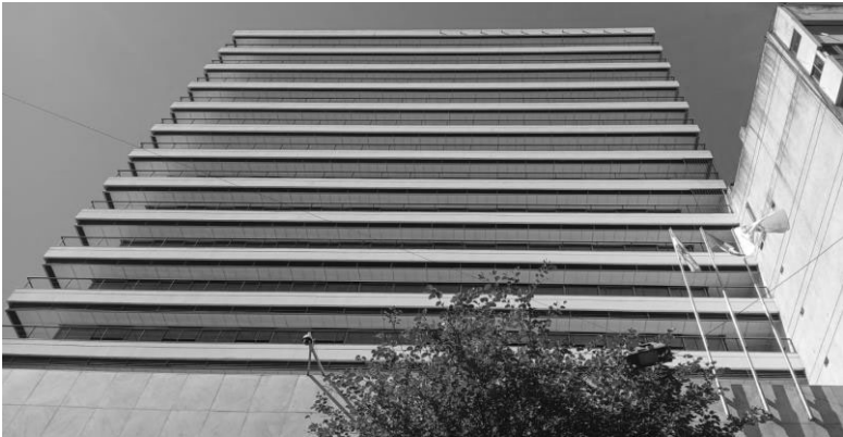
F42 La imagen muestra las tramas constructivas y los elementos en conjunto. Revestimiento, barandas, cielorrasos, parasoles y carpintería. La trama completa admite la regularidad entre los elementos. Edificio Bolsa de Comercio de Rosario.
