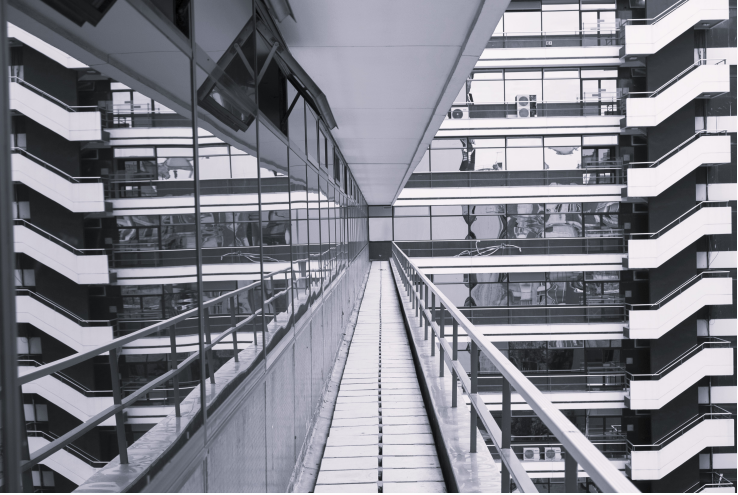
F20 La imagen muestra la organización formal de los elementos de la arquitectura y la secuencia compositiva espacial y visual. Edificio American Express. Esquina Arenales y Maipú. Bs. As. Mario Roberto Álvarez, Arquitecto. 1987-1989
