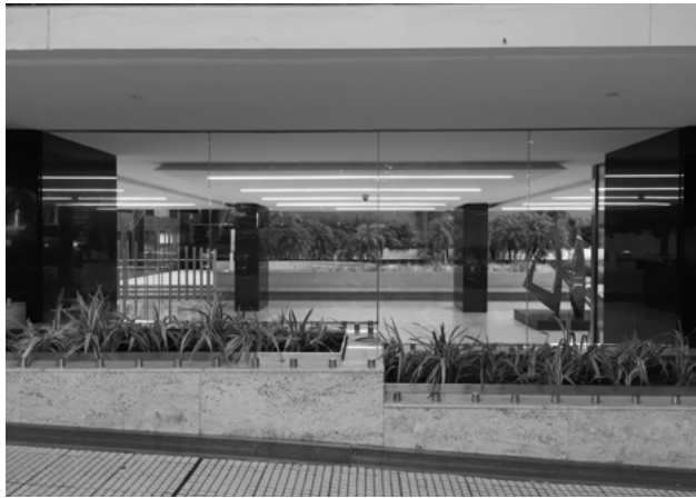
F19 Las imágenes muestran las relaciones visuales del hall de acceso del edificio American express y los vínculos que estructuran los pilares y la convergencia con tabiques y carpintería. Esquina Arenales y Maipú, CABA. Mario Roberto Álvarez, Arquitecto. 1987-1989
