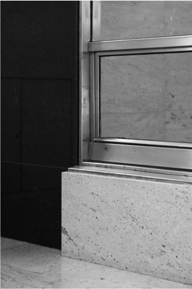
F45 La imagen muestra el detalle del Edificio American Express en la planta de acceso. Encuentro de diferentes elementos constructivos y sus respectivos materiales.
