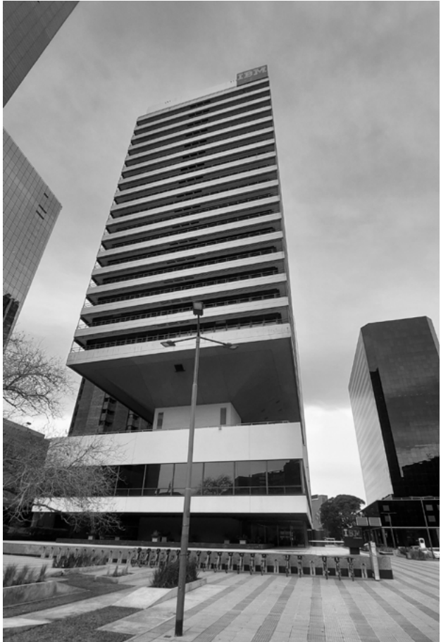
F3 La imagen muestra el Edificio IBM ubicado en Catalinas Norte, CABA, Cdad. Autónoma de Bs. As. MRA+A | Mario Roberto Álvarez y Asociados. Alvarez, Kopiloff, Santoro, Satow, Rivanera. Año: 1979-1983- Sup. terreno: 2.736 m² Sup. Total edificada: 32.000 m²
