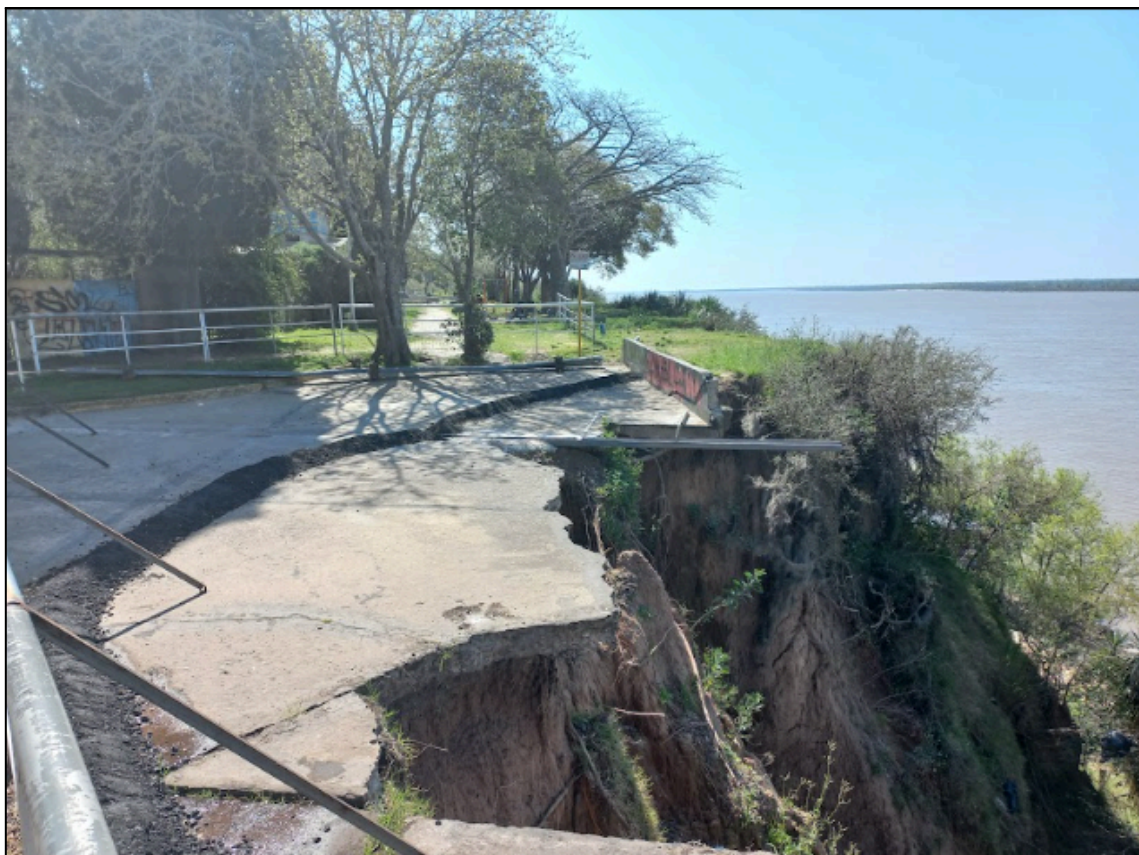
Imagen 1.4.5: Desmoronamiento de la barranca en la intersección con calle Sarmiento.
