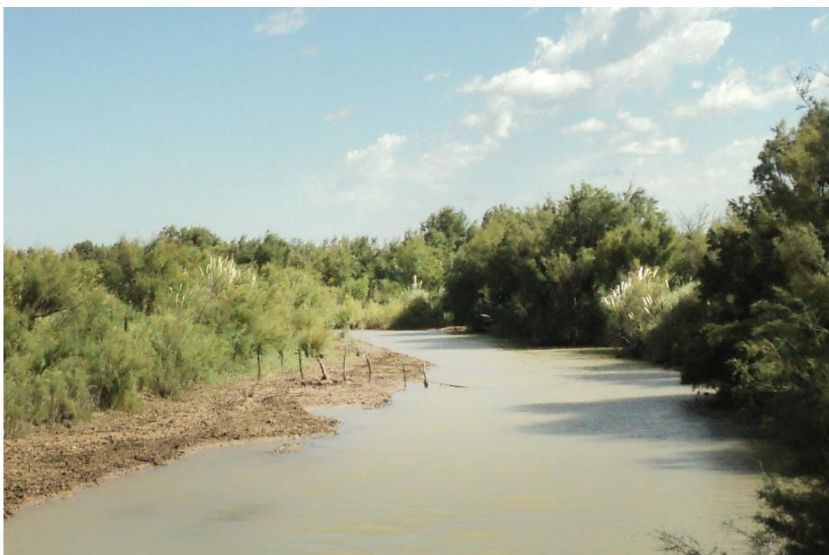
Figura 17. Alambrado sobre el cauce cuando viene el arroyo de La Barda
