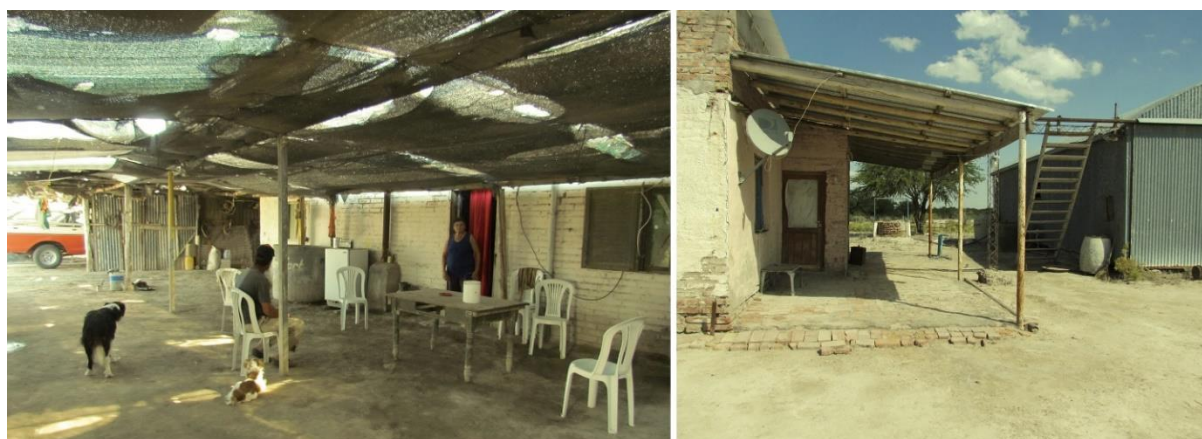
Figura 74. Plásticos y metales en la construcción de nuevos espacios
