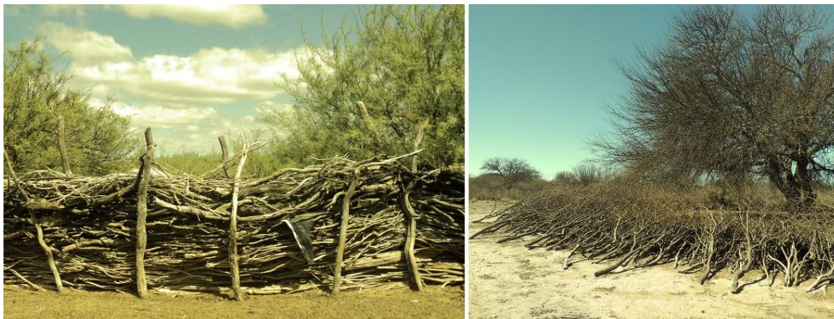
Figura 92. Izq. Corral con técnica de cajón. Der.: Algarrobos cortados para construir corrales con esta técnica
