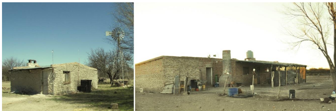
Figura 51. Puestos próximos al arroyo de La Barda
