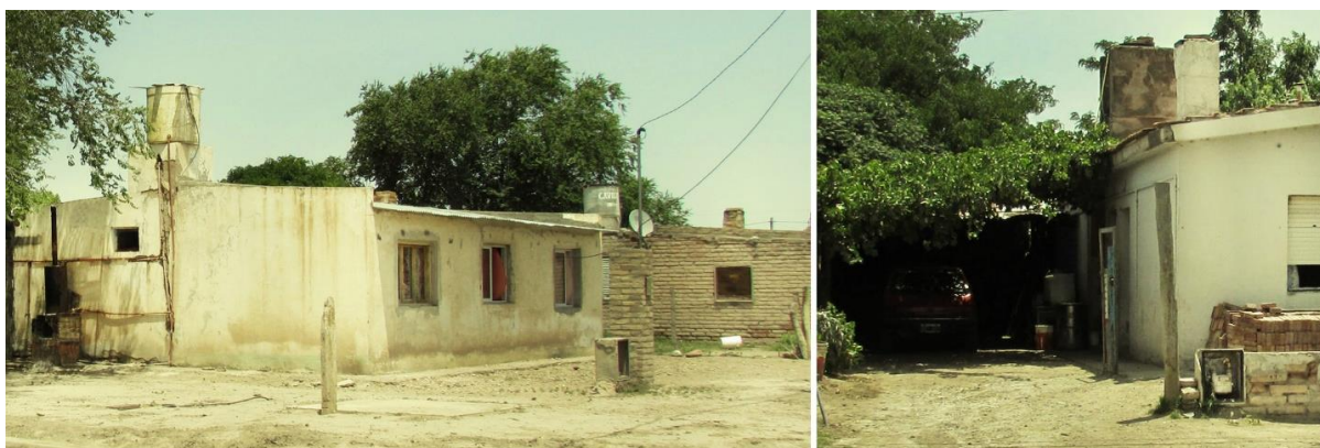
Figura 63. Chimeneas y calentadores de agua a leña conviven con la instalación de gas por red
