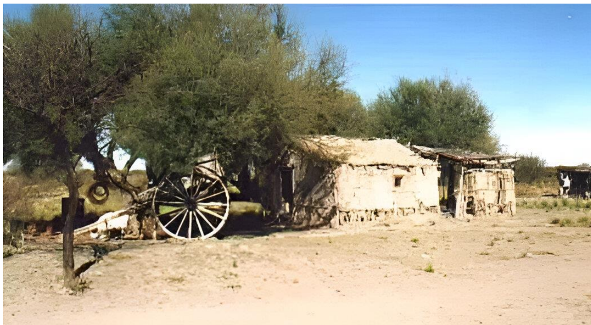
Figura 81. Puesto con quincha de jarilla, chorizo y cubierta de torta
