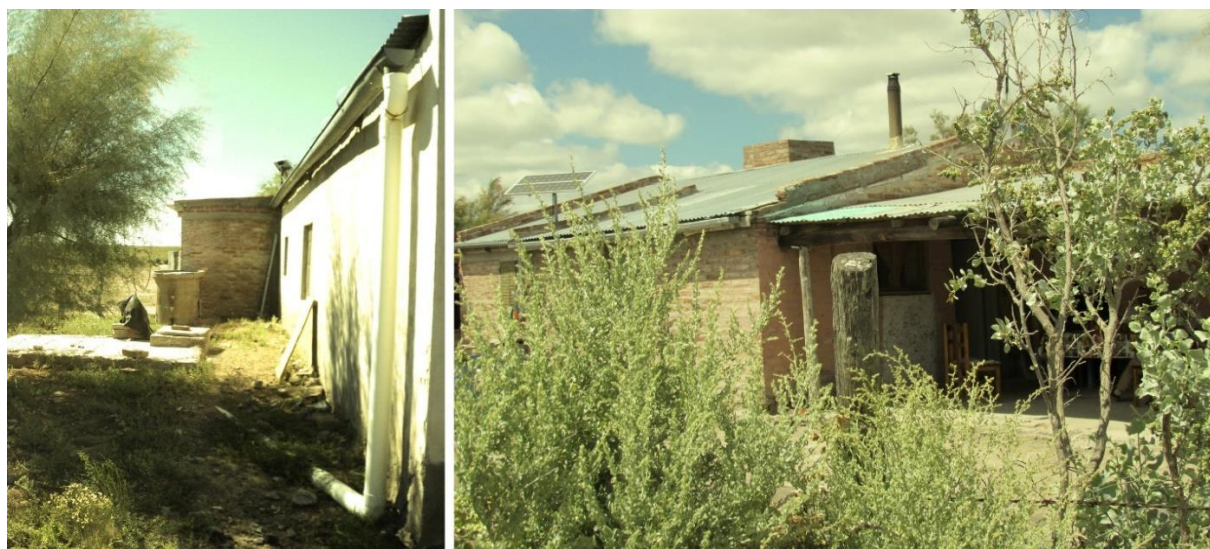
Figura 67. Izq.: Cisterna de mampostería a nivel de piso. Der.: Atriplex Nummularia en los bordes del guardapatio
