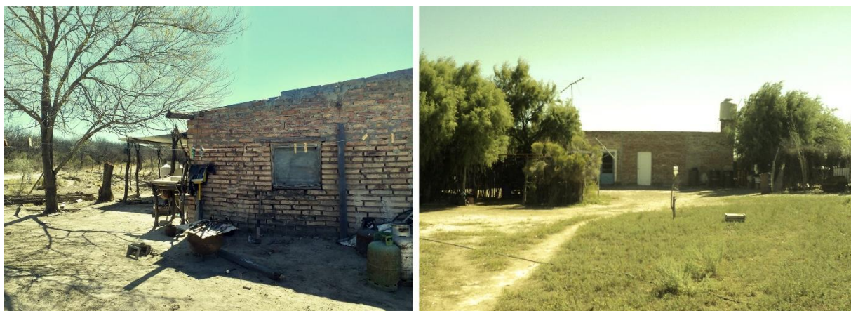
Figura 73. Casas construidas después de las inundaciones
