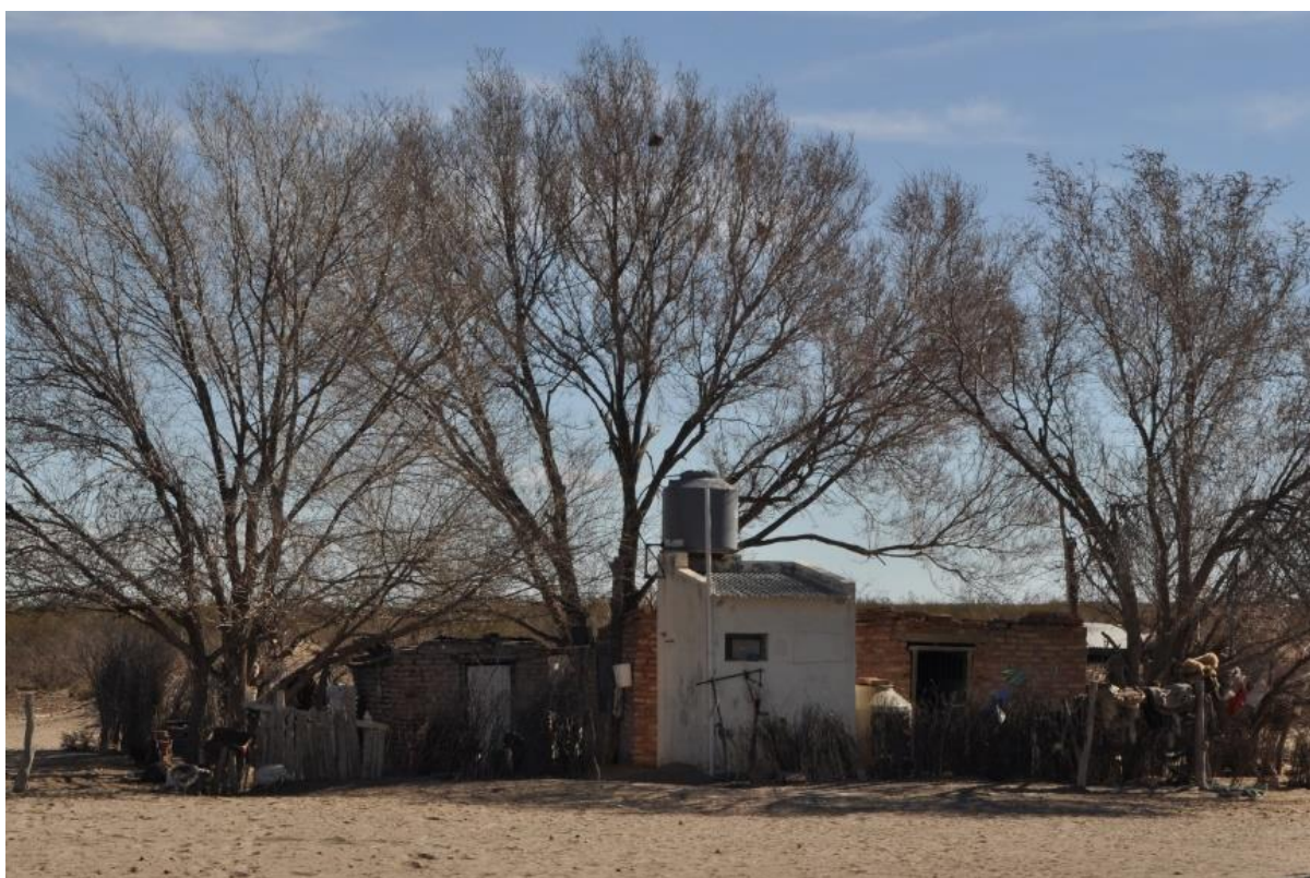
Figura 69. Módulo sanitario construido en puesto del sector de La Puntilla
