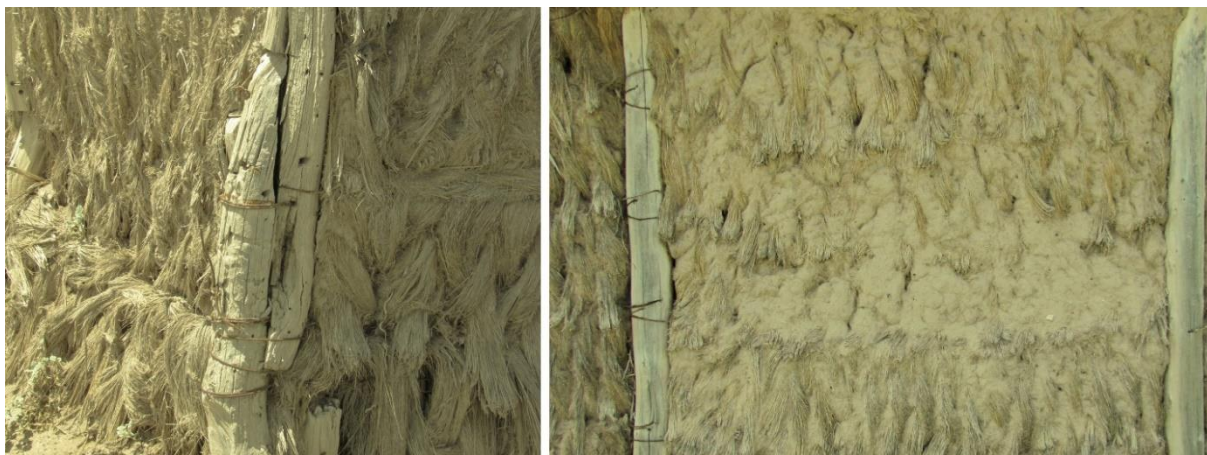
Figura 72. Casa construida con técnica de chorizo con tensores de alambre dulce
