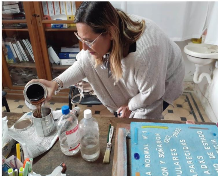
Imagen N° 8 y 9: terminaciones y acabado con barniz de la baldosa
