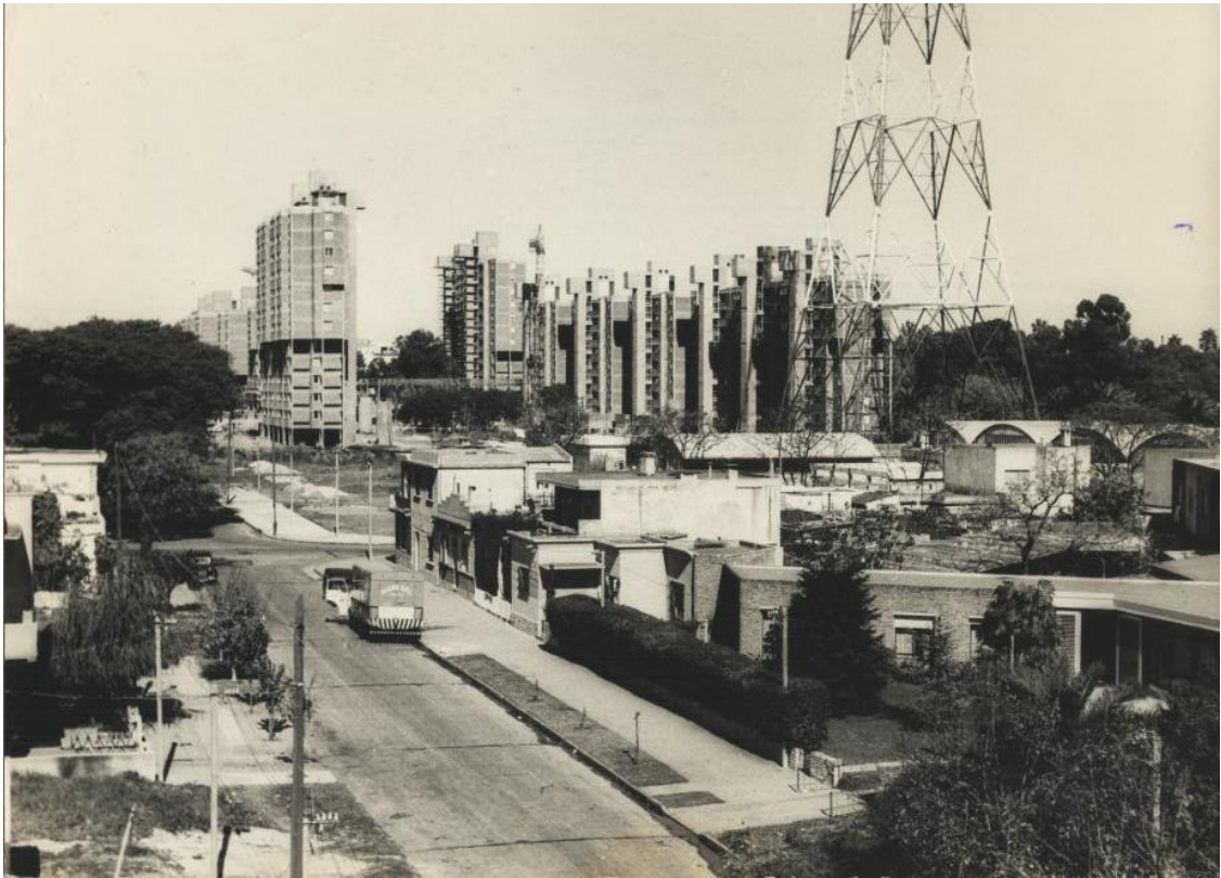
Figura 45. El Complejo Bulevar en construcción, visto desde la calle Quijote desde el norte. La fotografía expone el carácter de la zona, con casas de uno o dos niveles que caracterizaban el barrio. Fuente: Archivo de Thomas Sprechmann.
