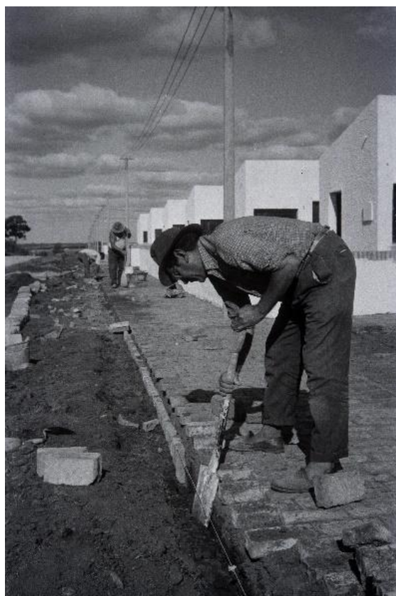
Figuras 60, 61 y 62. Cooperativistas colocando pavimentos de ladrillos en las áreas comunes internas y en los cordones de las veredas, la etapa final de la construcción de la cooperativa Isla Mala, en 25 de Mayo, Florida. Fuente: Fondo Mario Spallanzani, IH, FADU, Udelar.
