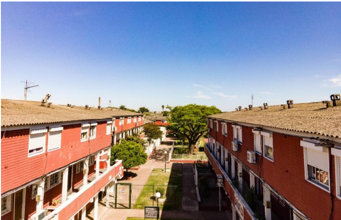
Figura 66. Conjunto de viviendas de la cooperativa 18 de Julio (Mesa 3). Vista de uno de los senderos peatonales, bordeados por unidades dúplex sobre locales comerciales y casas de un nivel, tomada desde el este a vuelo de dron. Fotografía: Fernando García Amen, 2022.
