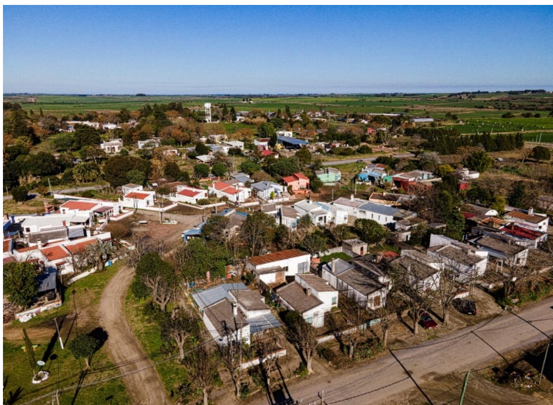
Figura 15. Vista del área del conjunto tomada a vuelo de dron desde el noreste en la que se puede ver el ingreso vehicular. Fotografía: Fernando García Amén, 2022.
