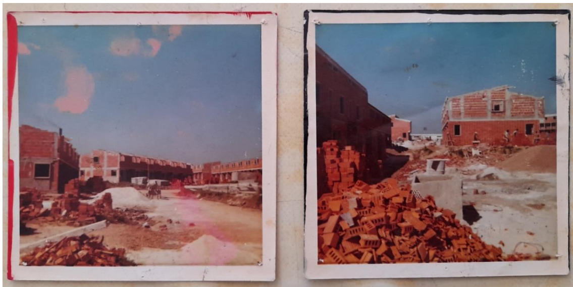
Figura 47 y 48. Integrantes de Covico trabajando en la obra del conjunto de la cooperativa Nuevo Amanecer. Fuente: Archivo de Covico, Nuevo Amanecer.
