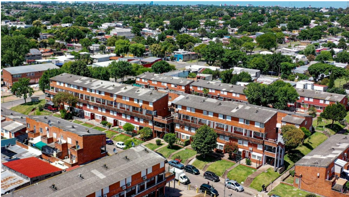
Figura 72. Conjunto de viviendas de la cooperativa Juana de América (Mesa 5). Vista de las calles vehiculares interiores y las unidades dúplex sobre dúplex tomada desde el este a vuelo de dron. Fotografía: Fernando García Amen, 2022.
