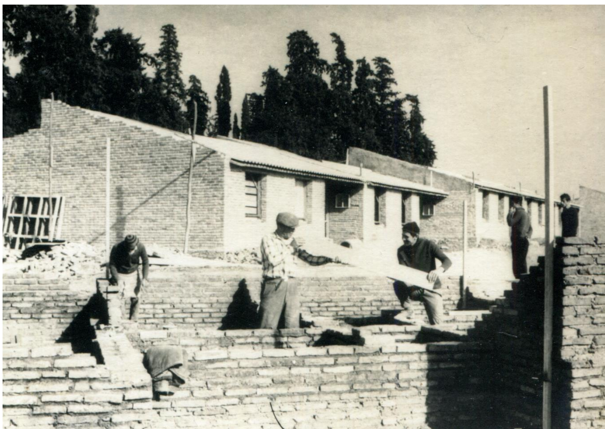
Figura 59. Cooperativistas realizando muros en áreas frontales en las viviendas de la cooperativa Éxodo de Artigas 1, Río Negro. Fuente: Fondo Mario Spallanzani, IH, FADU, Udelar.
