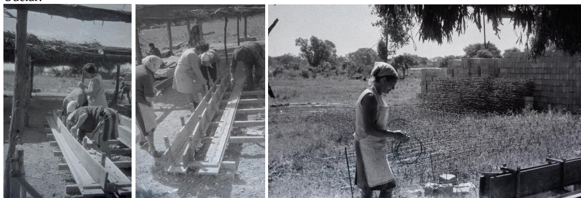
Figuras 49, 50 y 51. Cooperativistas armando los encofrados para las viguetas de hormigón armado para las cubiertas de las viviendas de las cooperativas Isla Mala y Éxodo de Artigas 1. Fuente: Fondo Mario Spallanzani, IH, FADU, Udelar.
