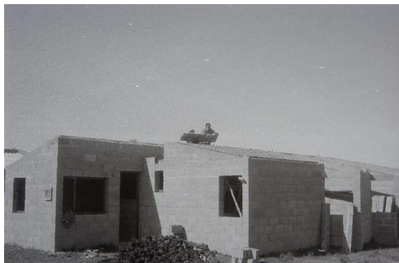
Figuras 53 y 54. Colocación de losetas de cerámica en las cubiertas de las viviendas de la cooperativa Isla Mala, en 25 de Mayo, Florida. Fuente: Fondo Mario Spallanzani, IH, FADU, Udelar.
