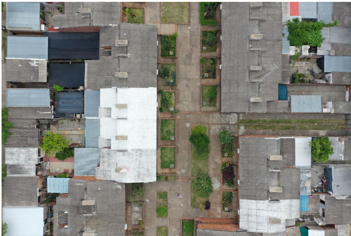
Figuras 15 y 16. Conjunto de viviendas para la cooperativa Covisan 2. Vista desde el este y vista cenital a vuelo de dron. Fotografía: Estudio Cattani, 2020.
