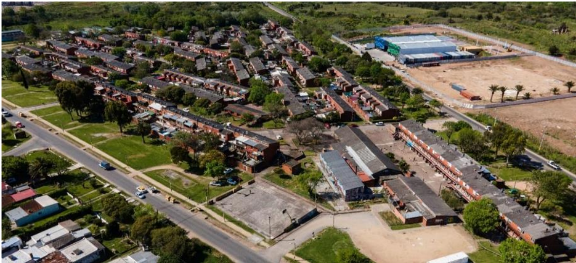
Figura 52. Conjunto de viviendas de la cooperativa Nuevo Amanecer. Perspectiva del conjunto a vuelo de dron vista desde el suroeste. Fotografía: Fernando García Amen, 2021.
