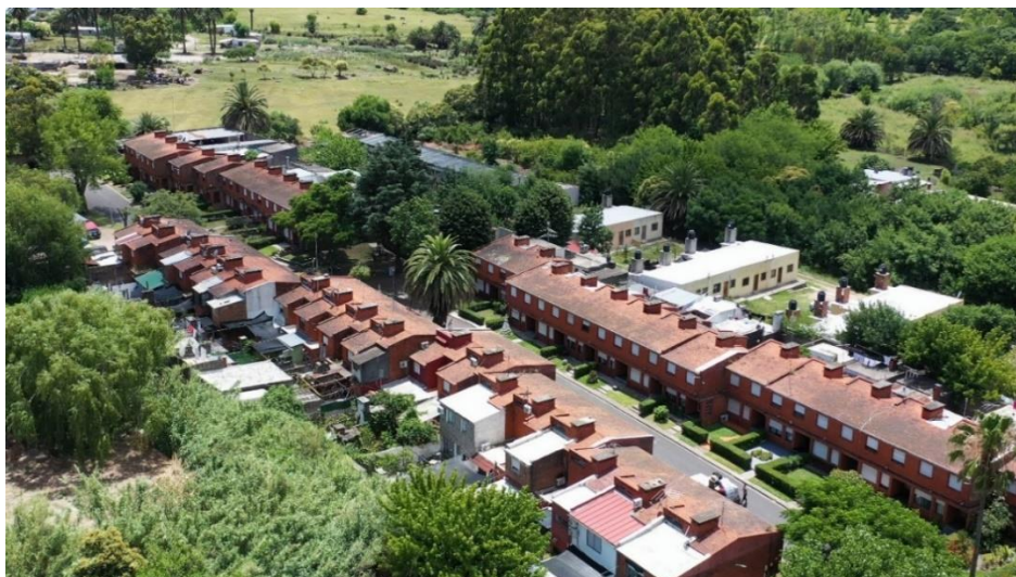
Figura 22. Conjunto de viviendas de la cooperativa Covim 2, en Montevideo. Vista desde el suroeste tomada a vuelo de dron. Fotografía: Fernando García Amen, 2022.
