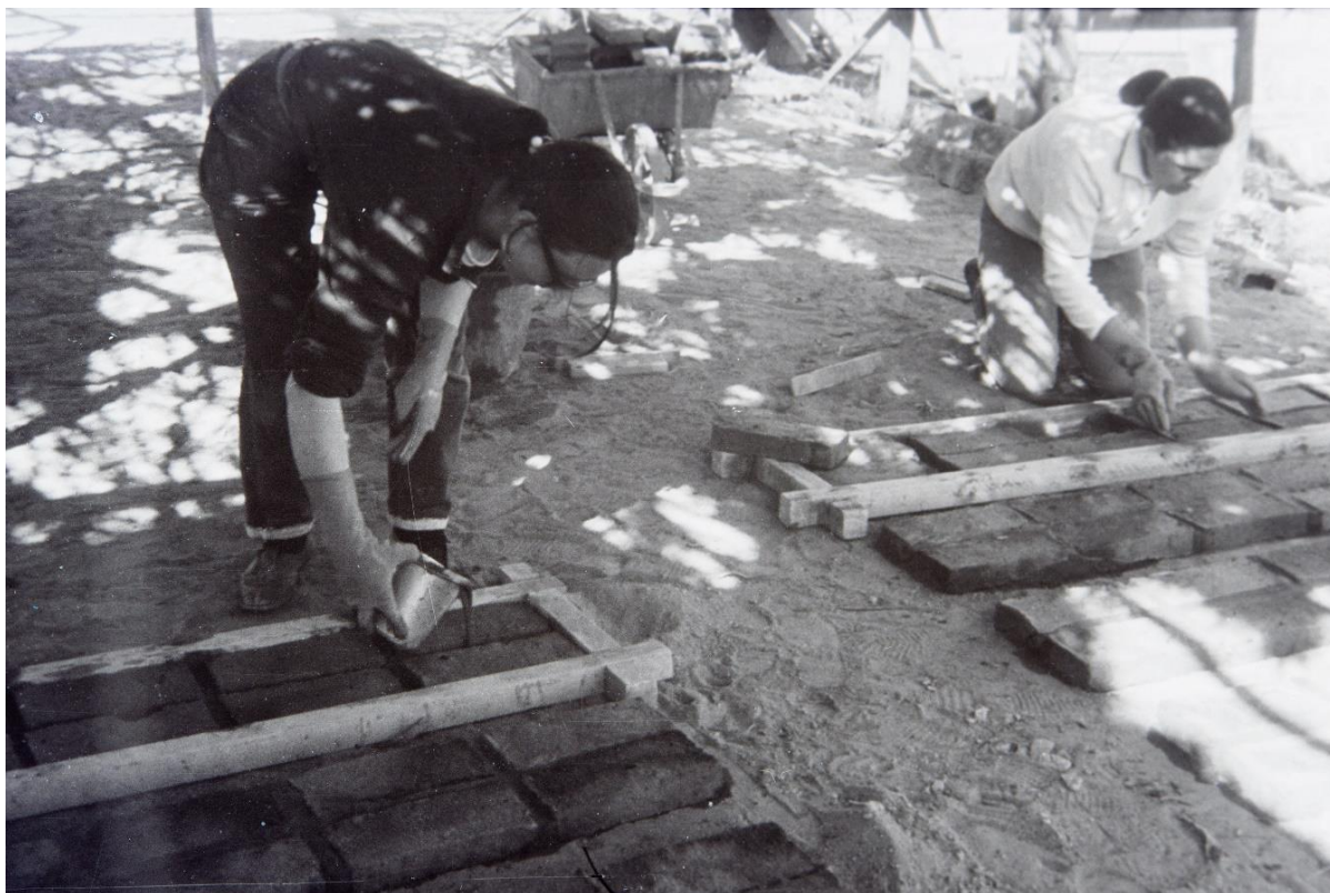
Figura 52. Cooperativistas armando losetas de ladrillo para las cubiertas de las viviendas de la cooperativa Cosvam, en Salto. Fuente: Fondo Mario Spallanzani, IH, FADU, Udelar.
