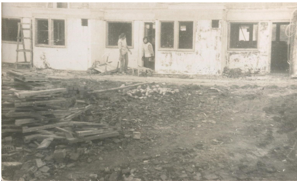
Figura 49. Integrantes de Covico trabajando en la obra del conjunto de la cooperativa Nuevo Amanecer. Fuente: Archivo de Covico, Nuevo Amanecer.
