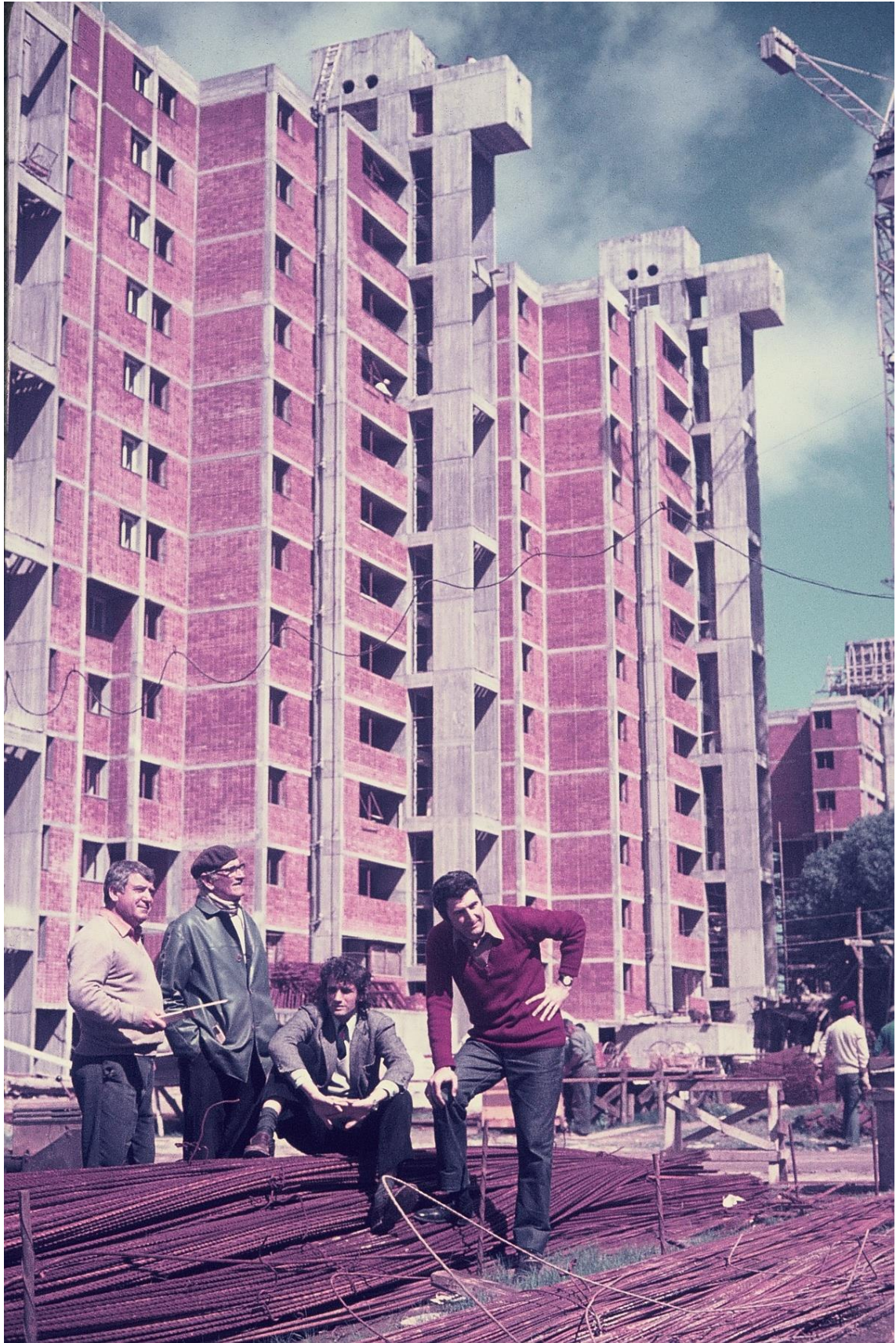
Figura 47. Sentado, al centro de la fotografía, el arquitecto Thomas Sprechmann, durante la construcción del Complejo Bulevar. Fuente: Archivo de Thomas Sprechmann.
