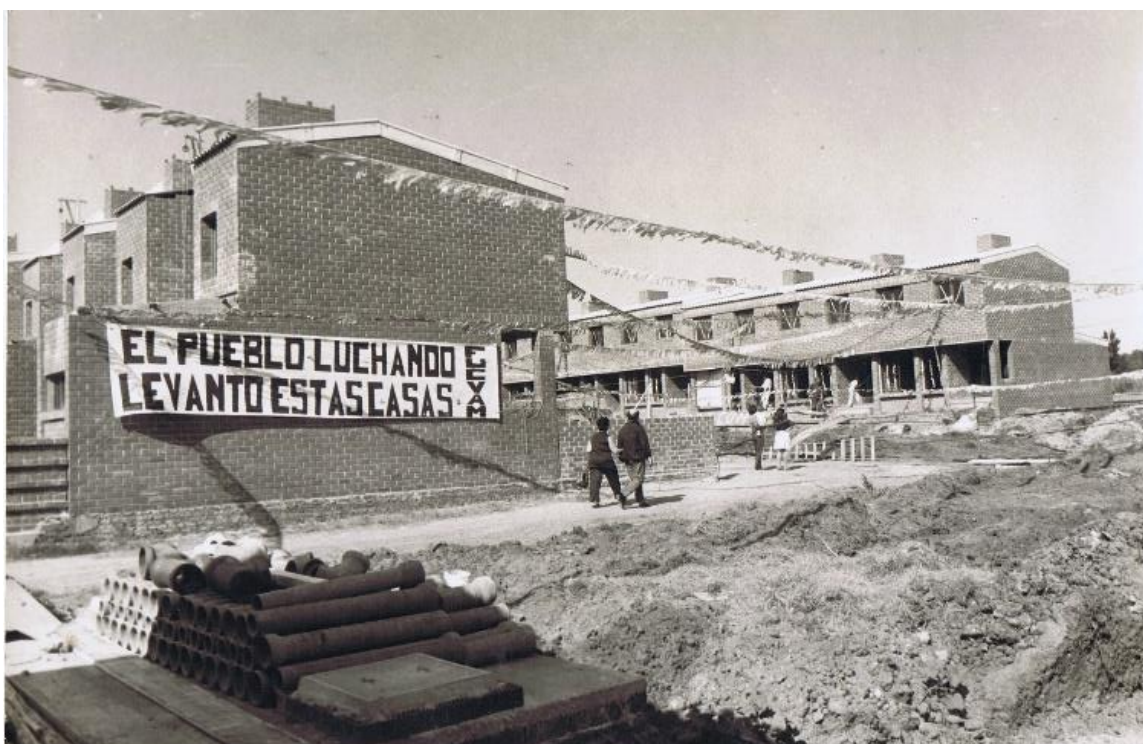
Figura 25. Vista del conjunto de viviendas para Covimt 3 en construcción. Fuente: Archivo de Fucvam.
