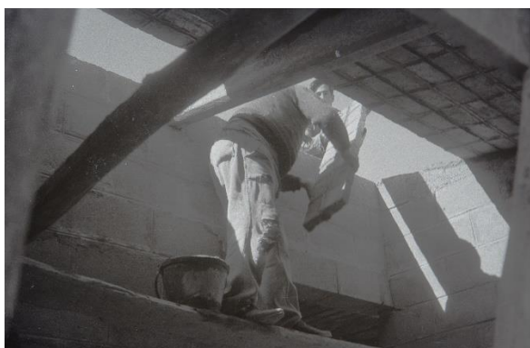
Figuras 53 y 54. Colocación de losetas de cerámica en las cubiertas de las viviendas de la cooperativa Isla Mala, en 25 de Mayo, Florida. Fuente: Fondo Mario Spallanzani, IH, FADU, Udelar.
