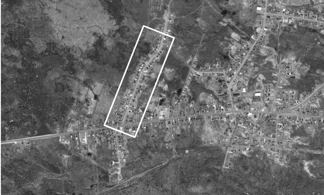
Figura 5. Vista satelital del conjunto tomada en 2003. Recuperada de Google Earth 46°10'51.82" N 60°01'34.98" O, agosto de 2023 ( https://www.google.com/maps/46.1803541,-60.0320949 ).
