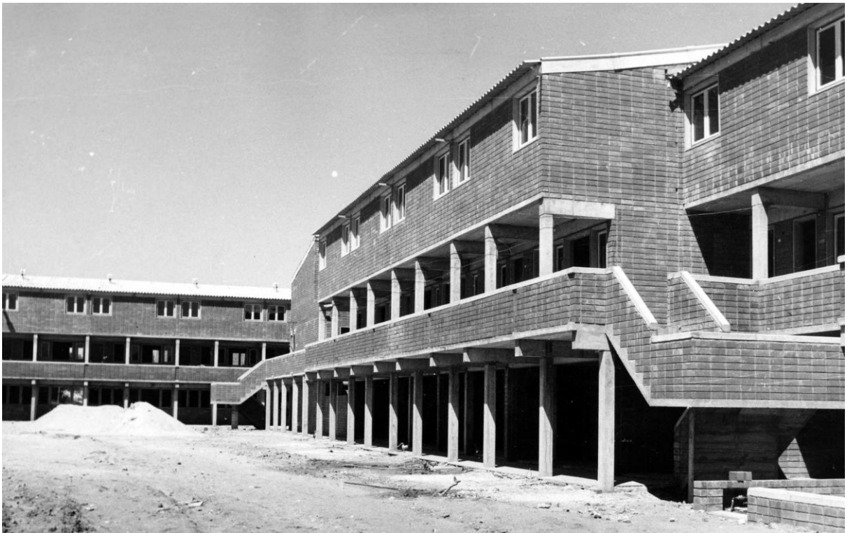
Figura 44. Vista de los corredores elevados de las unidades dúplex sobre viviendas de un nivel durante su construcción. Fotografía: César Lousteau. Fuente: Rafael Lorente Mourelle.
