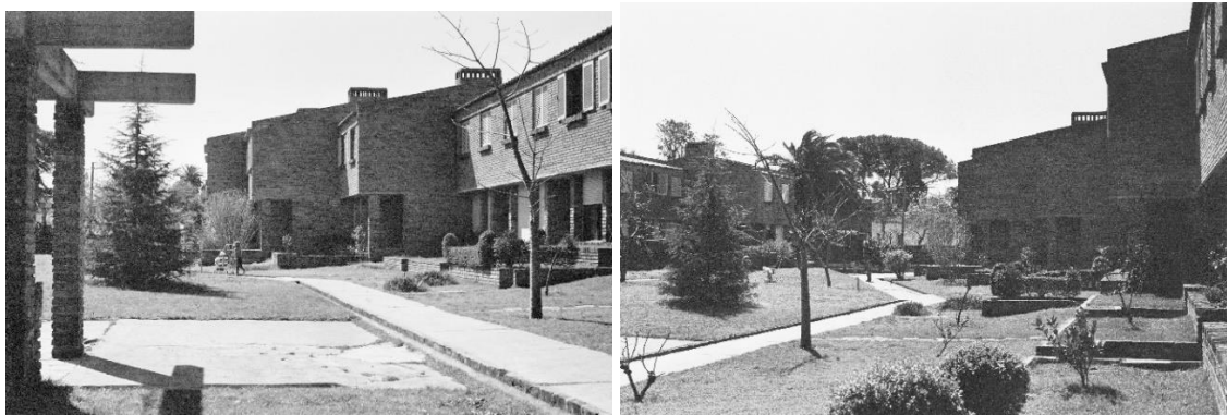
Figuras 17 y 18. Vistas de los muros medianeros de ladrillo visto a junta trabada. Fuente: Fondo Mario Spallanzani, IH, FADU, Udelar.
