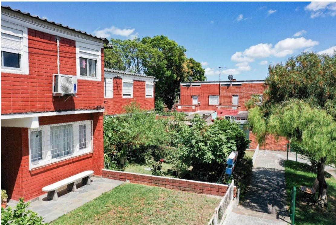
Figuras 21 y 22. Vista cenital y del interior del conjunto a vuelo de dron. Fotografías: Fernando García Amen, 2023.
