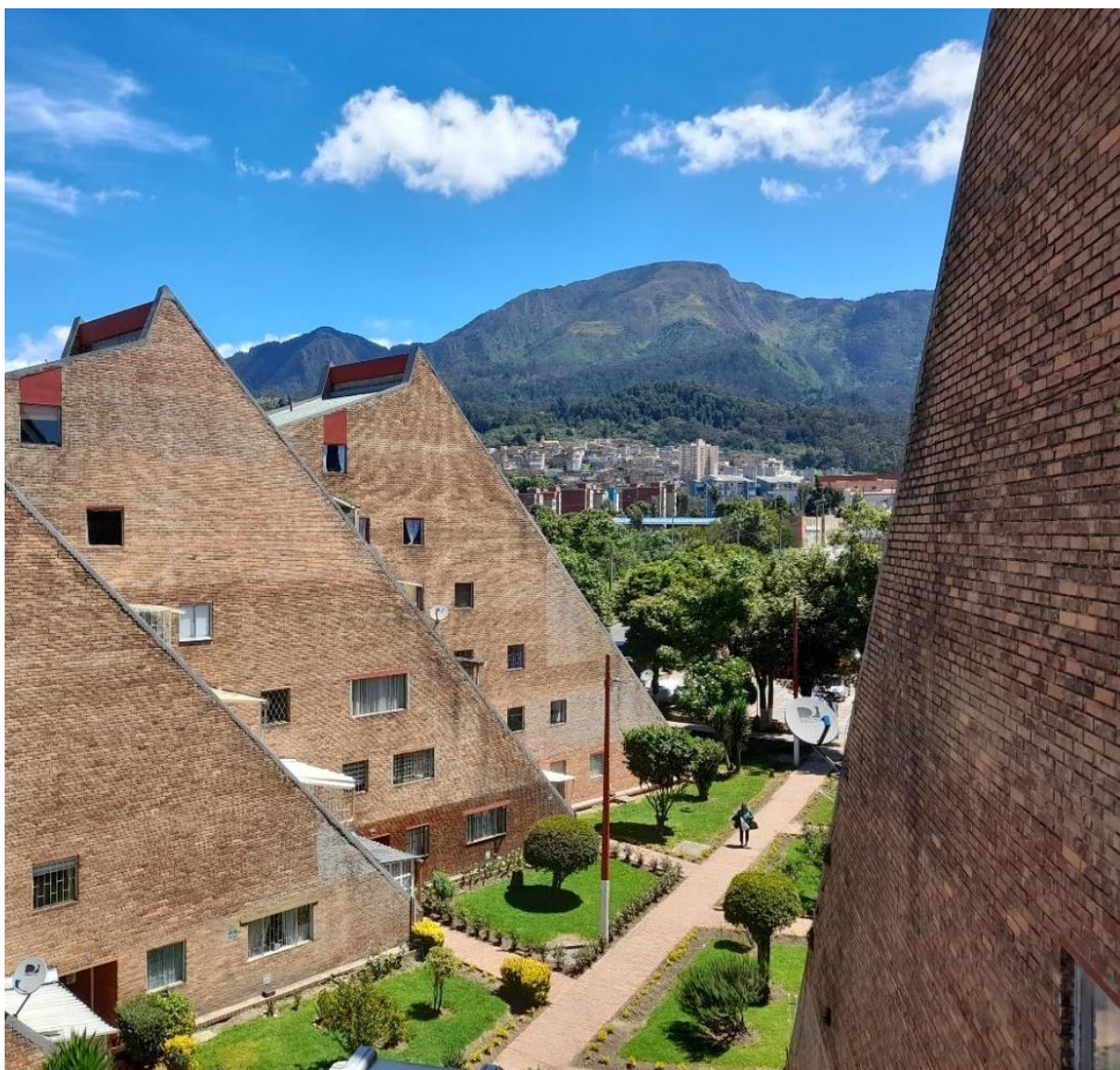
Figura 17. Vista del conjunto desde una de las terrazas de la tira ubicada más hacia el este. Fotografía: Mary Méndez, marzo de 2023.
