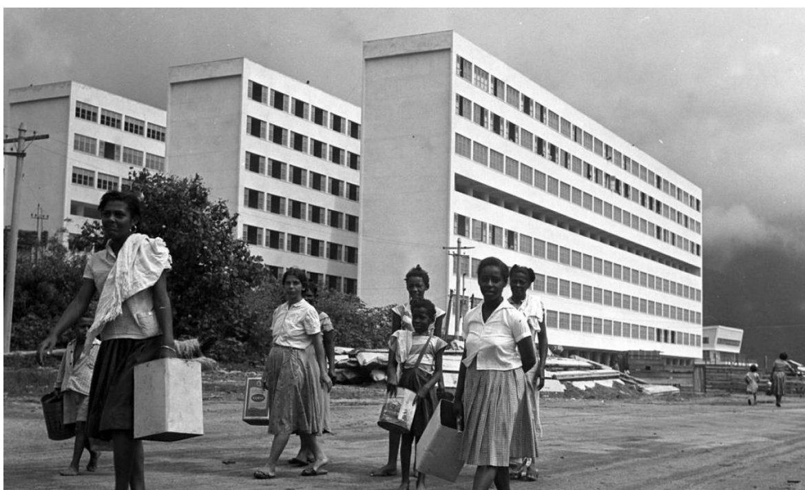
Figuras 12 y 13. Vistas de los bloques que componen el Conjunto San Sebastián. Imágenes tomadas de http://www.cronologiadourbanismo.ufba.br/apresentacao.php?idVerbete=1567#prettyPhoto .
