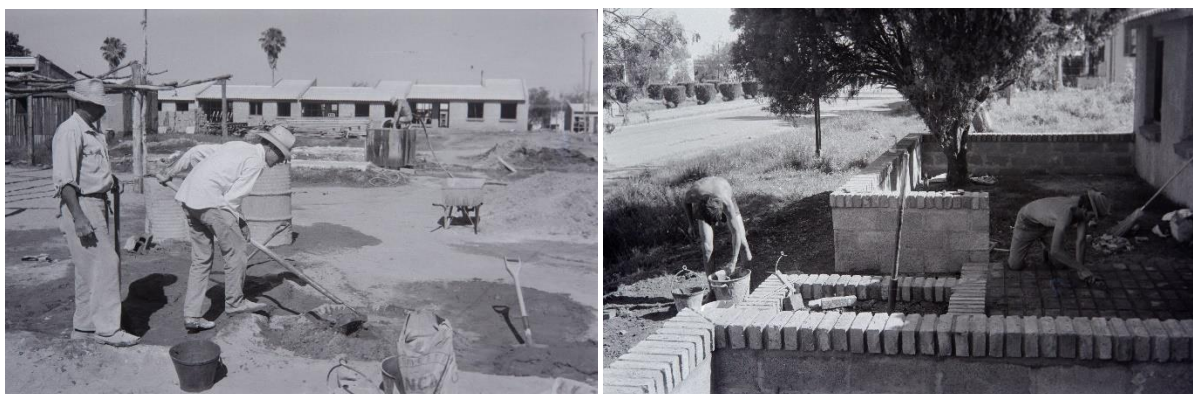
Figuras 57 y 58. Cooperativistas realizando muros y pavimentos de áreas frontales en las viviendas de la cooperativa Cosvam, en Salto. Fuente: Fondo Mario Spallanzani, IH, FADU, Udelar.
