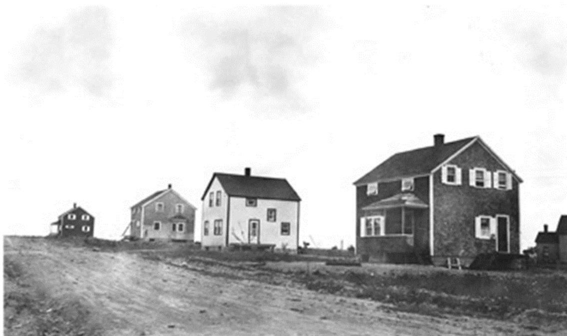
Figura 7. Vista de las casas construidas en Reserve Mines. Fotografía de Clara Dennis, fines de la década del 30. Imagen recuperada de https://archives.novascotia.ca/meninmines/archives/?ID=577 , en agosto de 2023.
