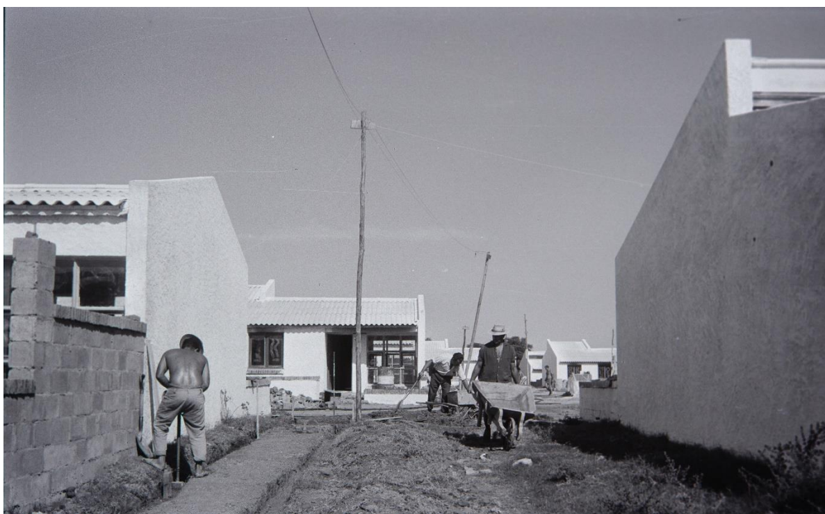
Figura 63. Cooperativistas realizando la caminería, en la etapa final de la construcción de la cooperativa Cosvam, en Salto. Fuente: Fondo Mario Spallanzani, Archivo DDI. IH, FADU, Udelar.
