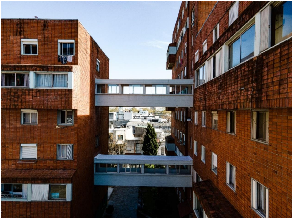
Figura 50. Conjunto de viviendas para la cooperativa Ucovi. Vista de los corredores elevados que conectan las torres tomada desde el norte a vuelo de dron. Fotografía: Fernando García Amen, 2021.
