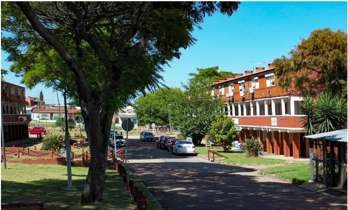
Figura 69. Conjunto de viviendas de la cooperativa 3 de Abril (Mesa 4). Vista general de una calle vehicular interior bordeada por unidades dúplex sobre locales comerciales y viviendas de un nivel tomada desde el norte a vuelo de dron. Fotografía: Fernando García Amen, 2022.
