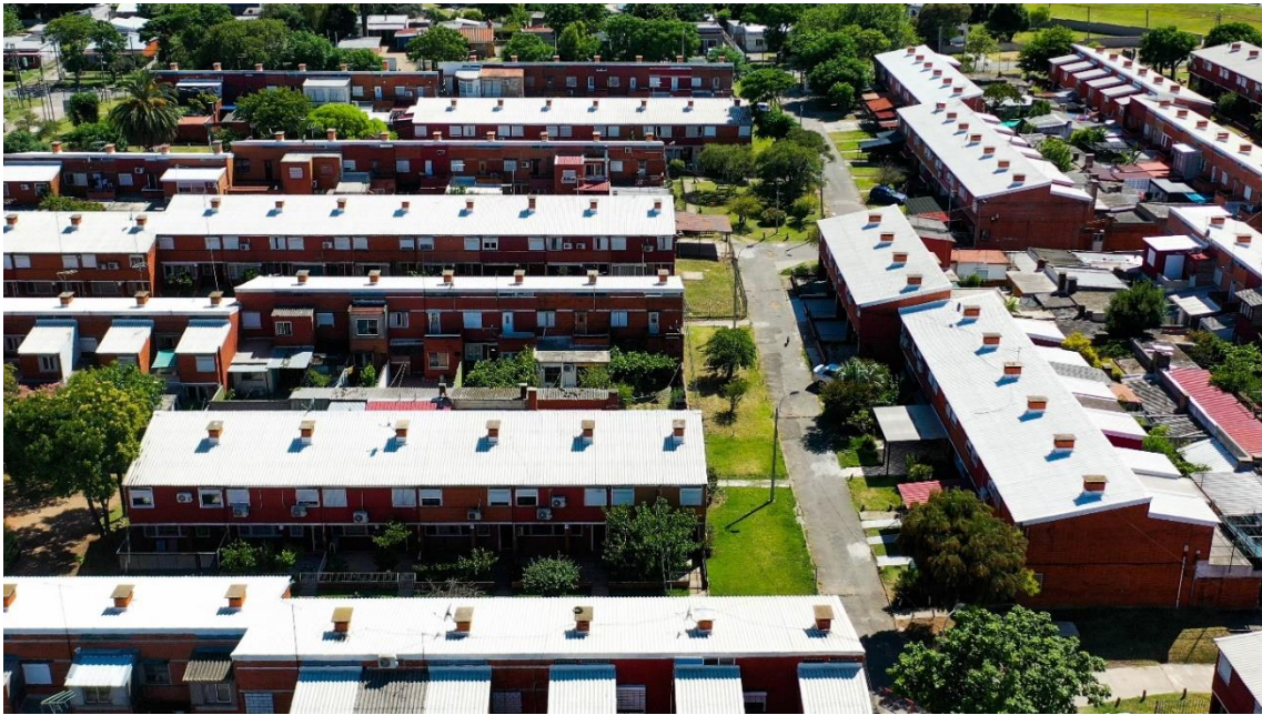
Figura 68. Conjunto de viviendas de la cooperativa 3 de Abril (Mesa 4). Vista general tomada desde el este a vuelo de dron. Fotografía: Fernando García Amen, 2022.
