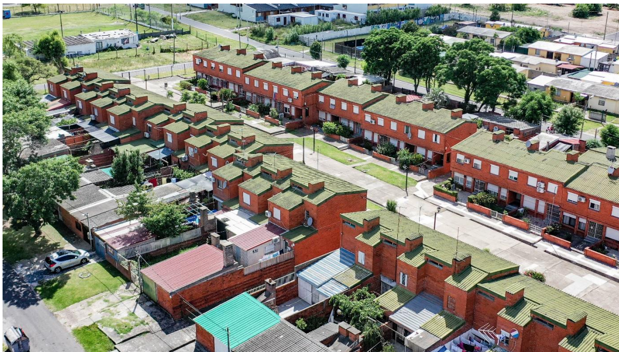
Figura 27. Conjunto de viviendas de la cooperativa Covmit 3, en Montevideo. Vista de la calle interior desde el oeste tomada a vuelo de dron. Fotografía: Fernando García Amen, 2022.
