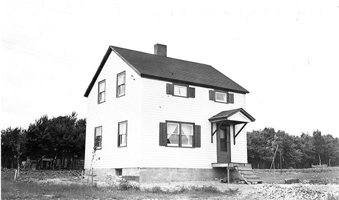
Figura 6. Vista de las casas construidas en Reserve Mines. Fotografía de Clara Dennis, fines de la década del 30. Imagen recuperada de https://archives.novascotia.ca/meninmines/archives/?ID=577 , en agosto de 2023.
