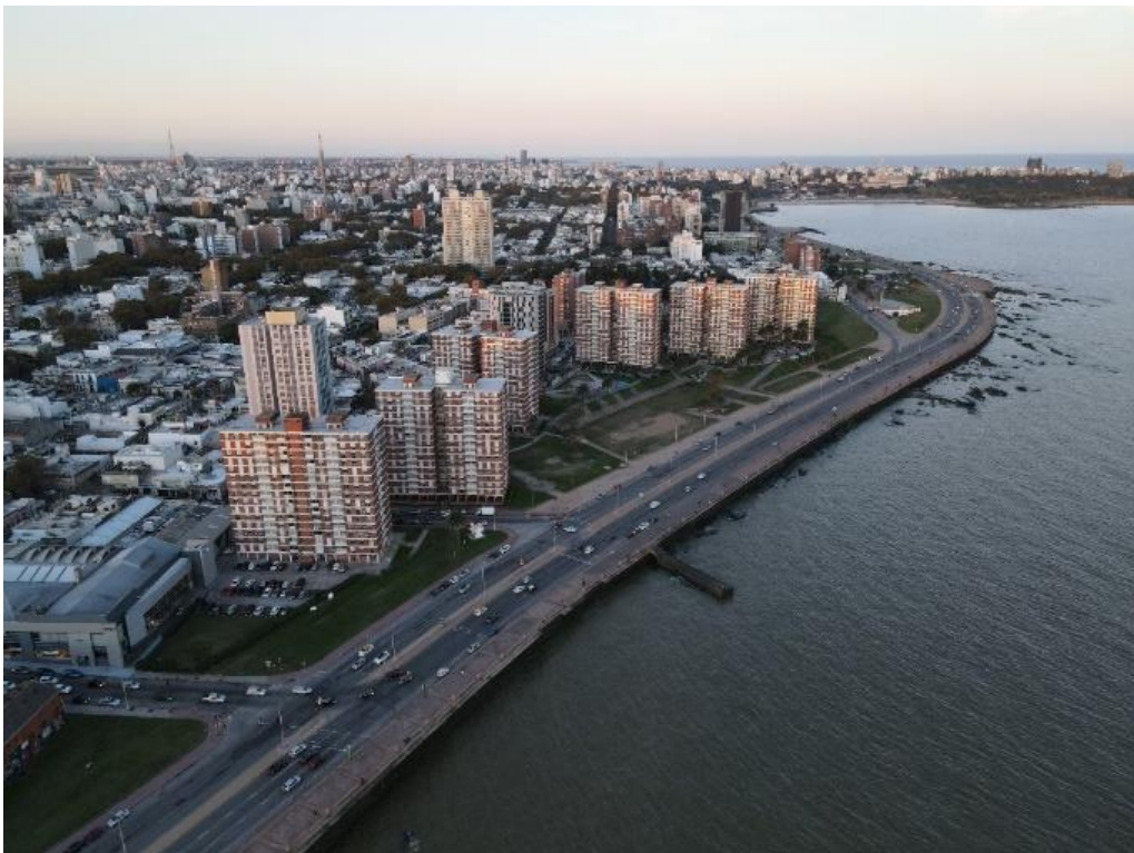
Figura 2. Unidad Habitacional del Barrio Sur. Perspectiva del conjunto a vuelo de dron. Fotografía: Martín Cajade, 2022.
