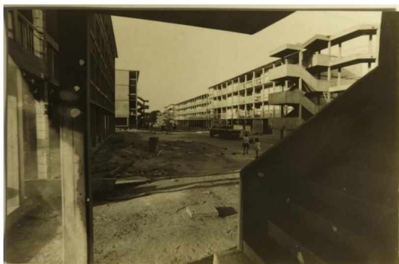
Figura 37. Cooperativa José Pedro Varela, Zona 1. Vista de la relación entre los bloques y la estructura circulatoria. Fuente: Fondo Cubría, Archivo DDI, IH, FADU, Udelar.
