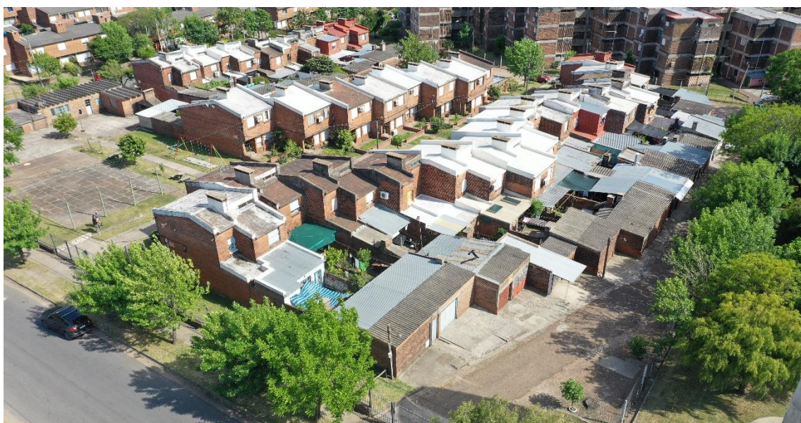
Figuras 13 y 14. Conjunto de viviendas para la cooperativa Covisan 1. Vista cenital y vista desde el este a vuelo de dron. Fotografía: Estudio Cattani, 2020.
