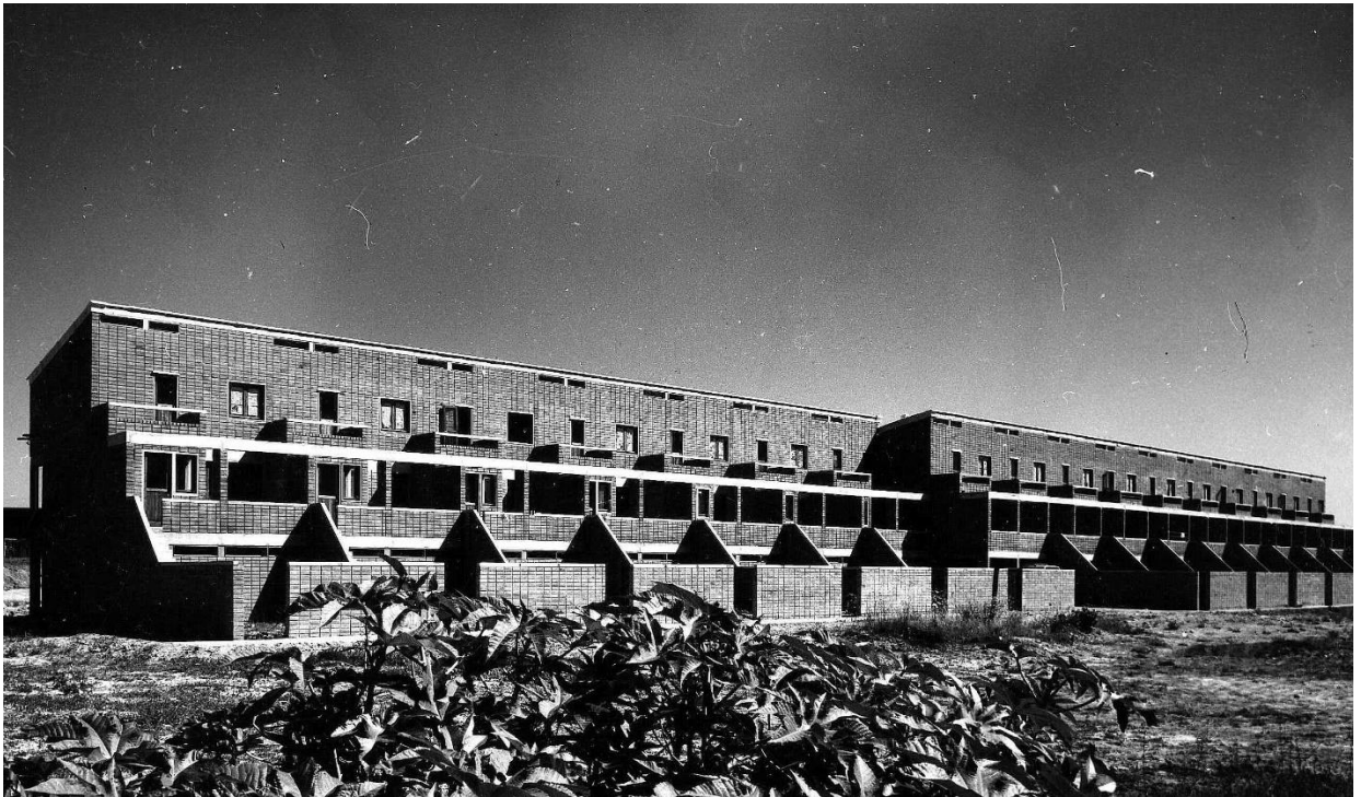
Figura 43. Vista posterior de las unidades dúplex sobre viviendas de un nivel durante su construcción. Fotografía: César Lousteau. Fuente: Rafael Lorente Mourelle.
