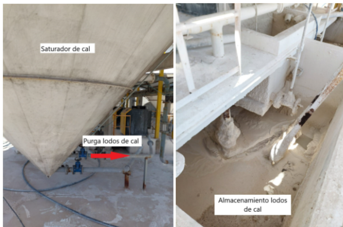
Figura N°17 - Saturadores de cal.
