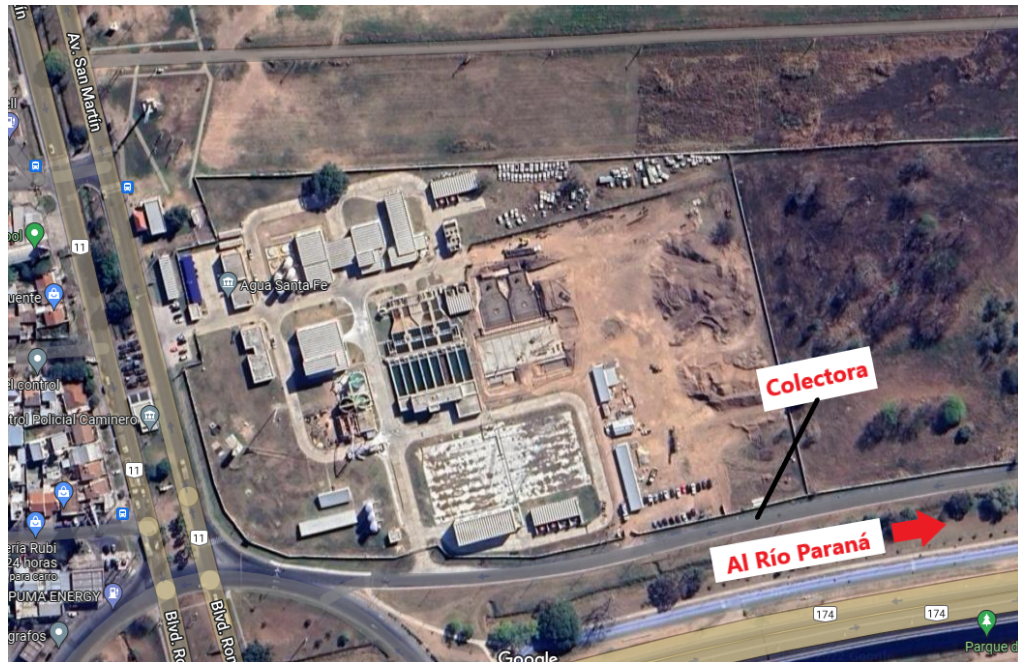
Figura N°127 - Colectora al sur de la Planta por la cual se encuentra el colector de 1500mm que descarga en el Río Paraná.
