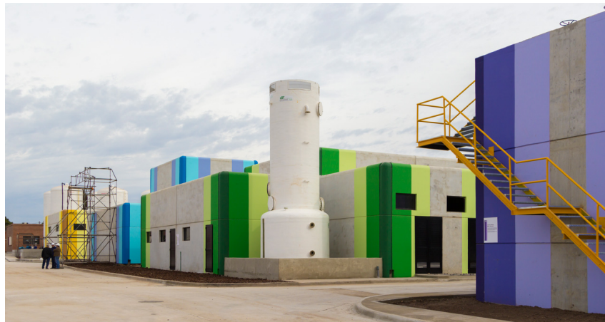
Figura N°40 - Terminación exterior de los edificios existentes en la Planta Potabilizadora de Baigorria.
