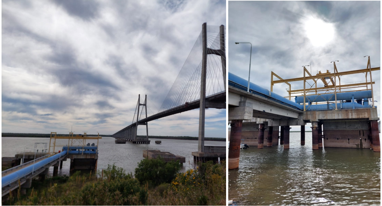
Figura Nº12 - Muelle de toma de la planta a orillas del Río Paraná, ubicado al norte del Puente Rosario-Victoria.
