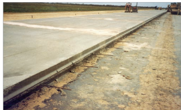
Figura N°109 - Junta longitudinal de construcción o ensamblada con machimbre trapezoidal y barras de unión. 31
