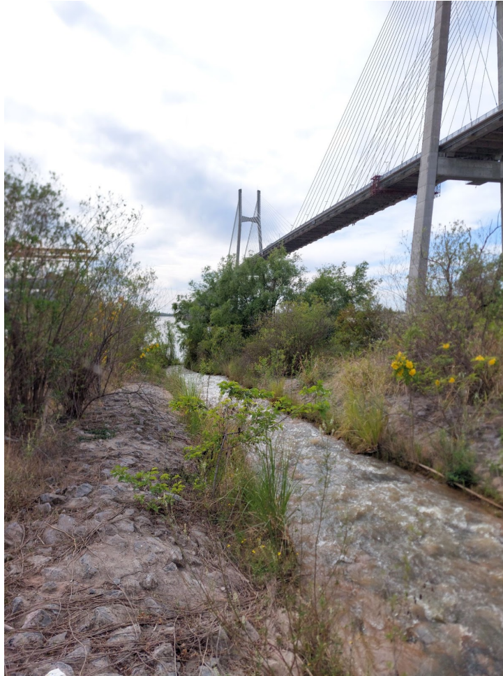
Figura Nº118 - Descarga de lodos hacia el Río Paraná. Foto 2.
