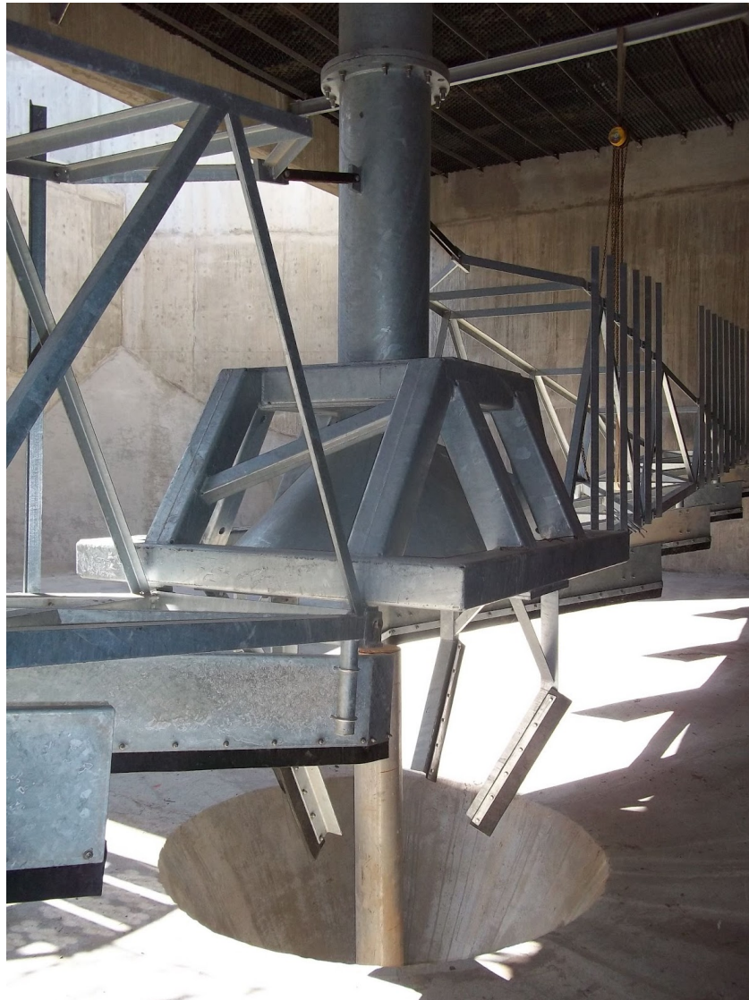
Figura Nº15 - Fondo de la cámara de decantación, en donde se espesan los lodos, se concentran en el fondo y se retiran mediante dos caños.
