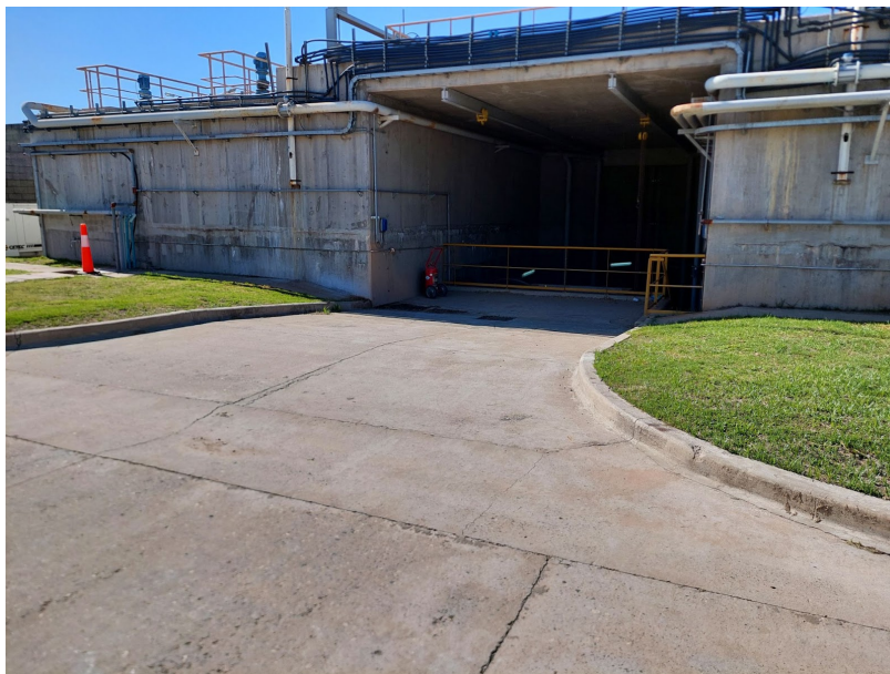
Figura N° A.13.16 - Pr 115,00m (vista hacia el sur). Ingreso a Módulo de Tratamiento I
