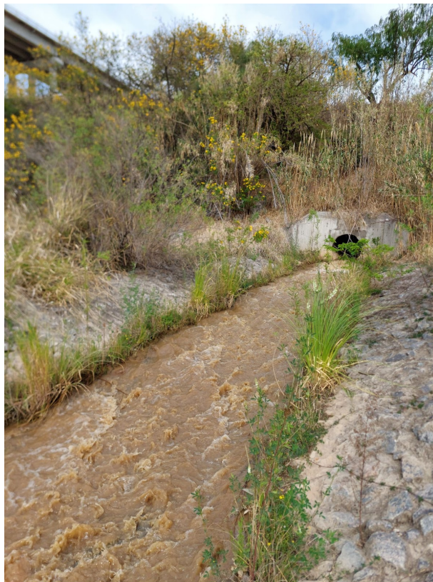
Figura Nº117 - Descarga de lodos hacia el Río Paraná. Foto 1.
