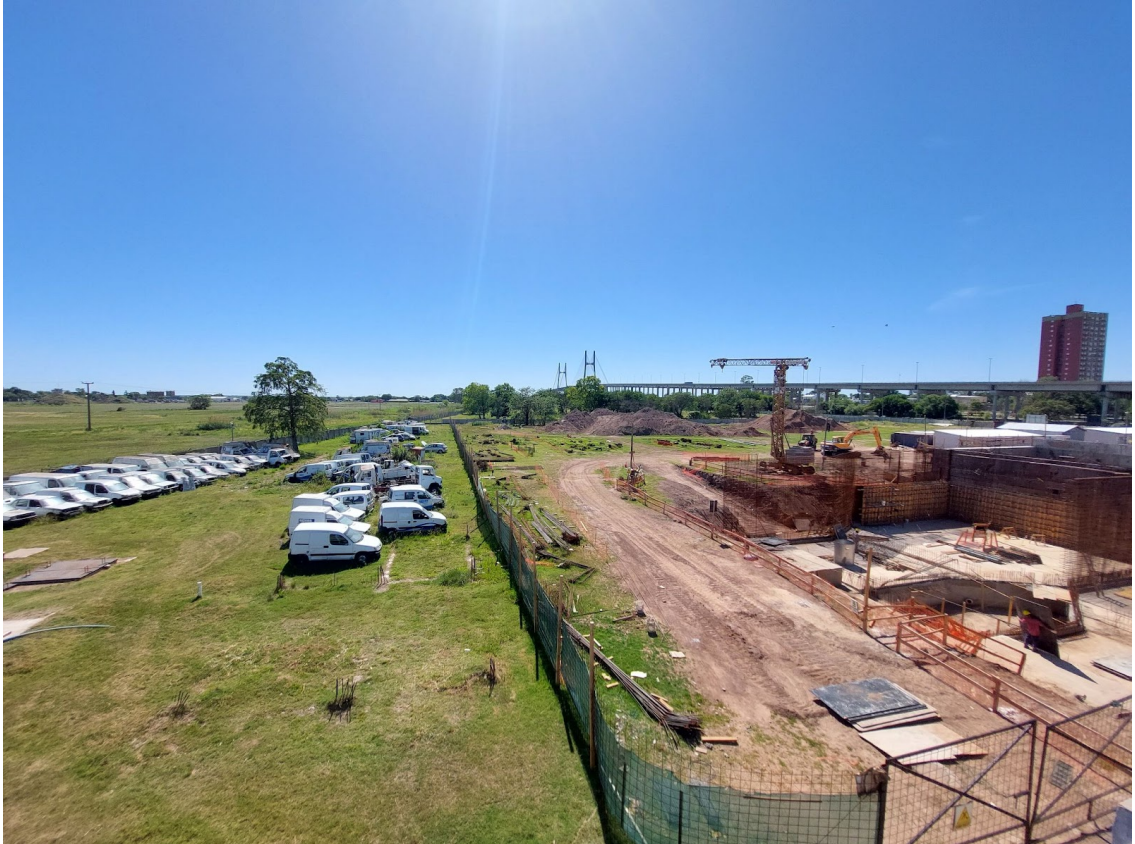
Figura Nº A.14.1 - Zona de emplazamiento de los Edificios de Tratamiento de Lodos I y II (a izquierda del cerco) y tramo de calle a pavimentar (a derecha del cerco).
