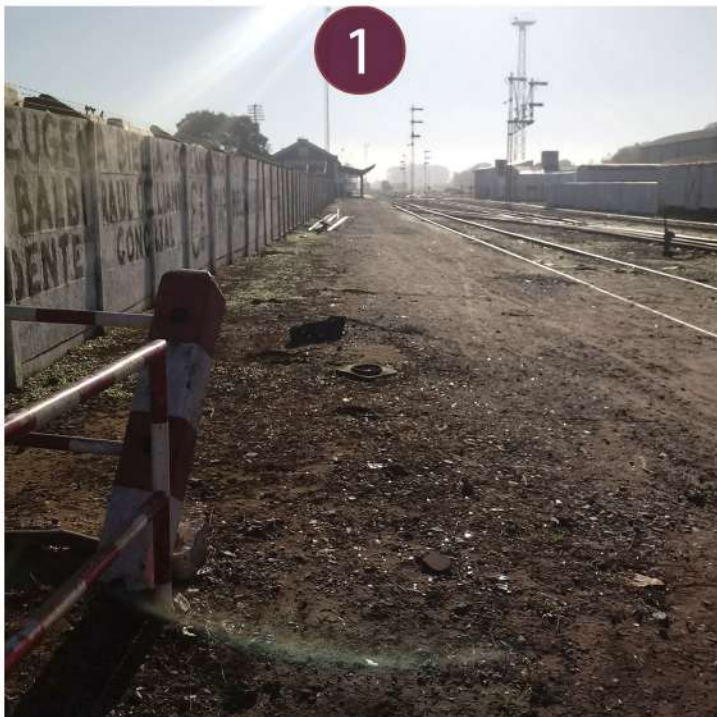
FALTA DE ACCESIBILIDAD
